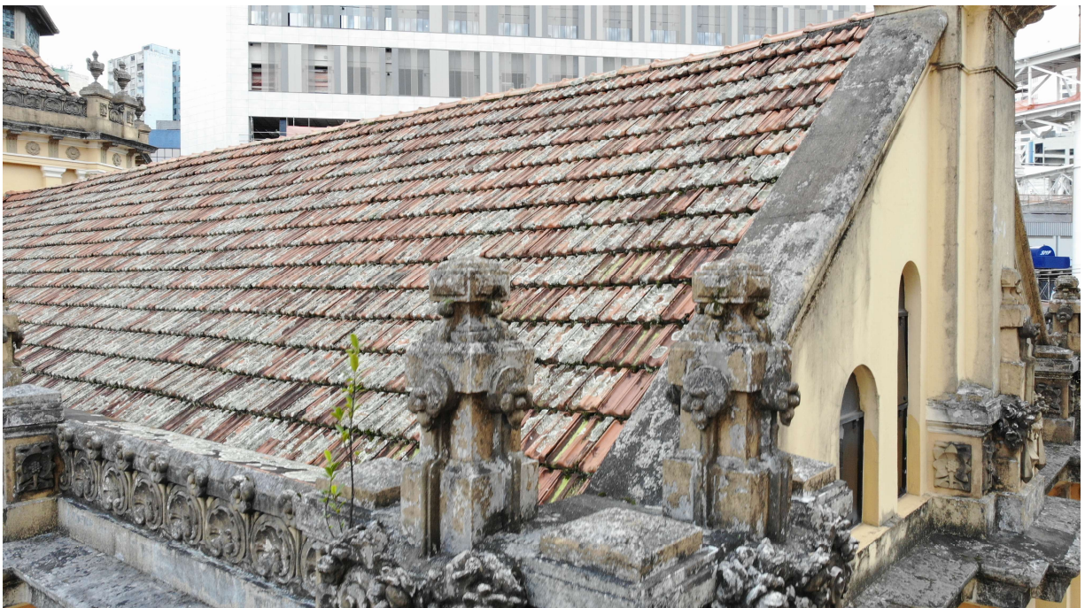
Figura 40- Fachada em foto capturada por drone
