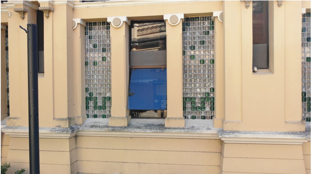
Figura 38 - Fachada em foto capturada por drone
