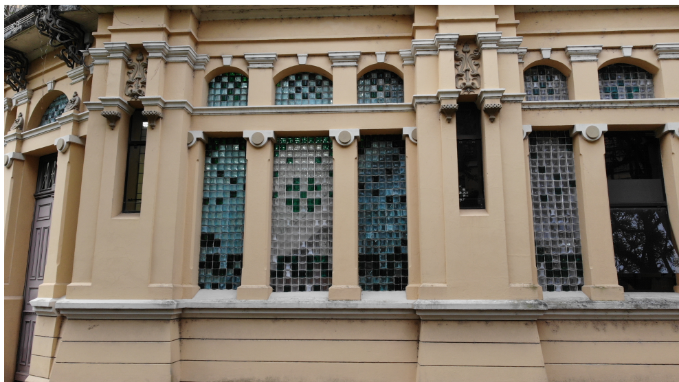
Figura 36 - Fachada em foto capturada por drone
