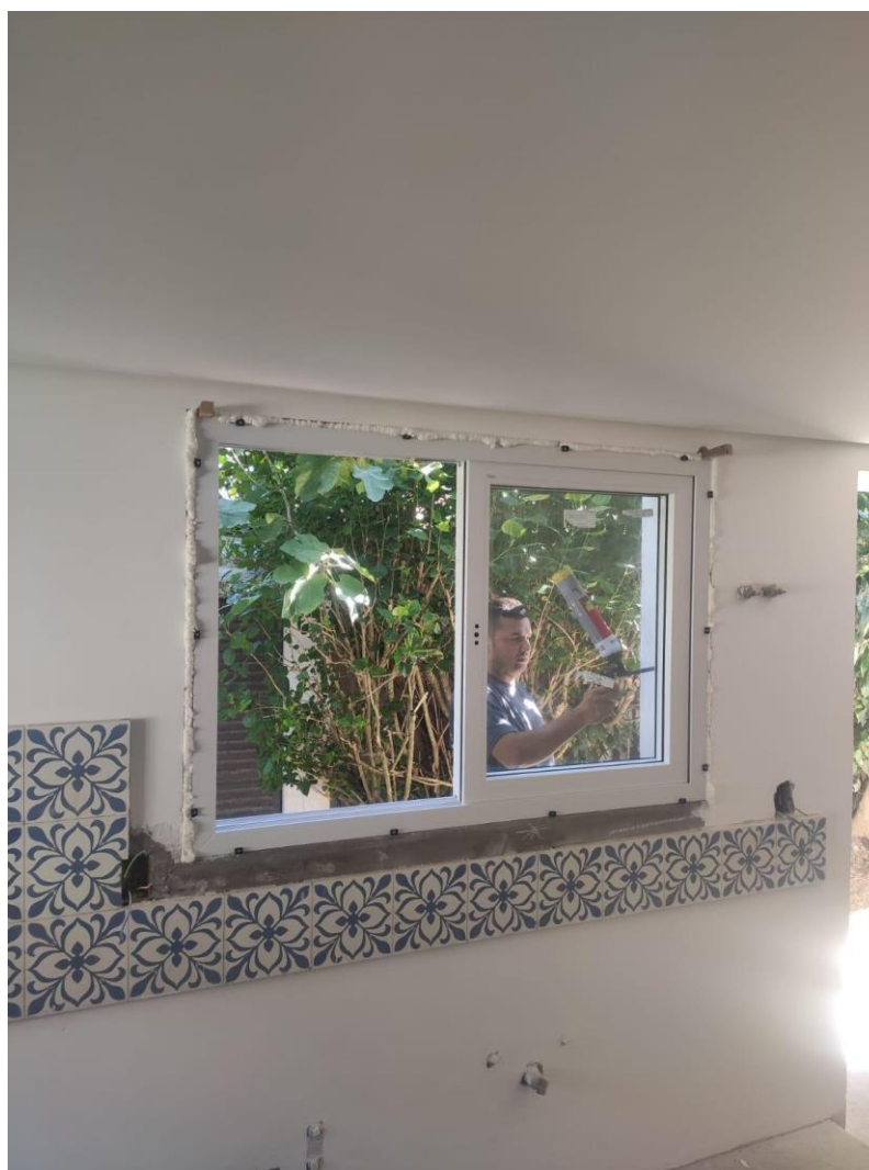
Figura 25 - Esquadria de PVC em processo de instalação
