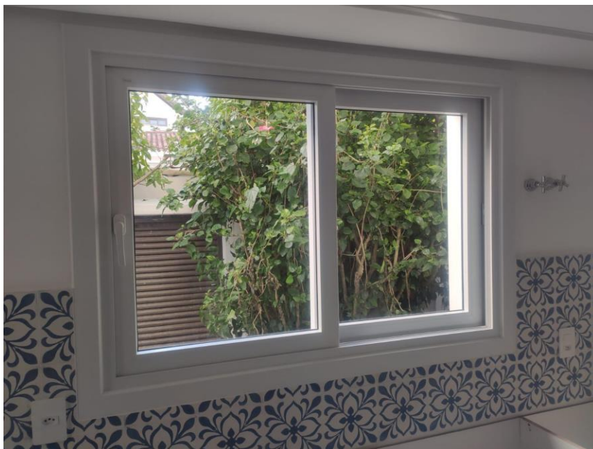
Figura 27 - Esquadria de PVC completamente instalada na edificação
