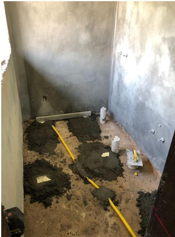
Figura 10 - Registro da execução de contrapiso de regularização em banheiro da edificação
