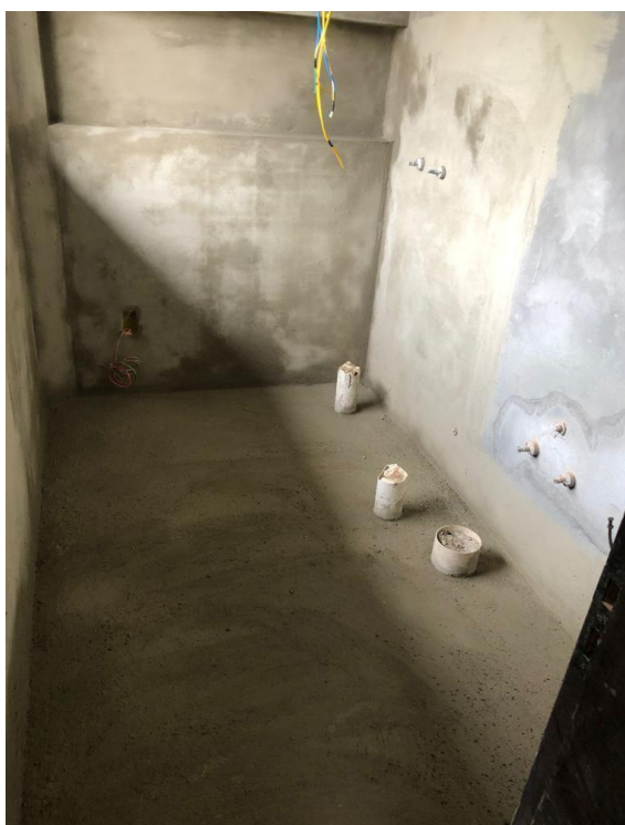
Figura 15 - Banheiro impermeabilizado pronto para recebimento do revestimento cerâmico
