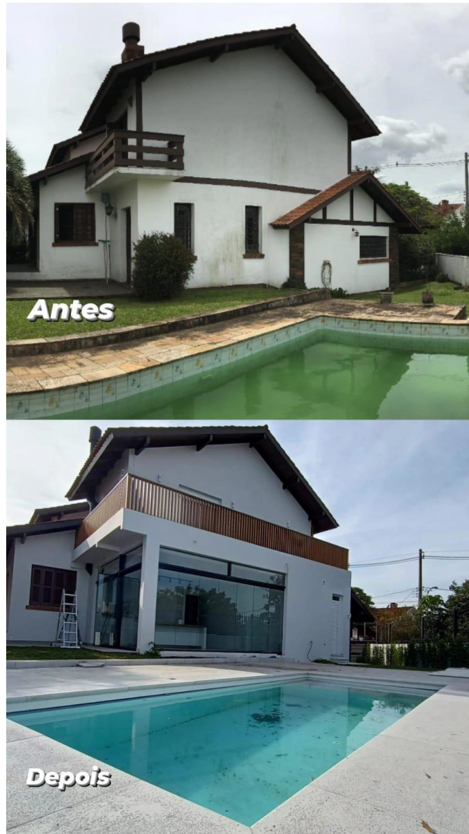
Figura 3 - Registros da edificação antes e após a realização da obra
