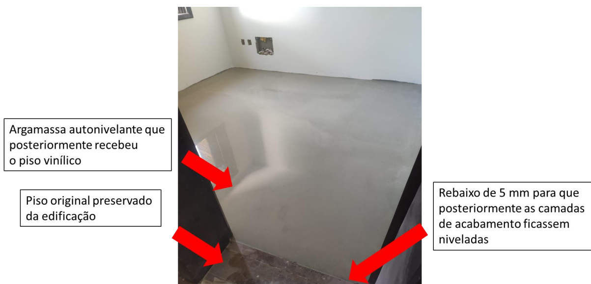
Figura 9 - Registro da utilização de argamassa autonivelante em dormitório da edificação
