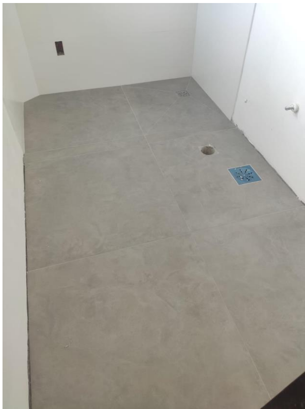
Figura 12 - Banheiro da edificação com o revestimento de porcelanato concluído
