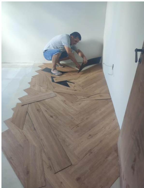
Figura 11 - Registro da instalação de piso vinílico em dormitório da edificação
