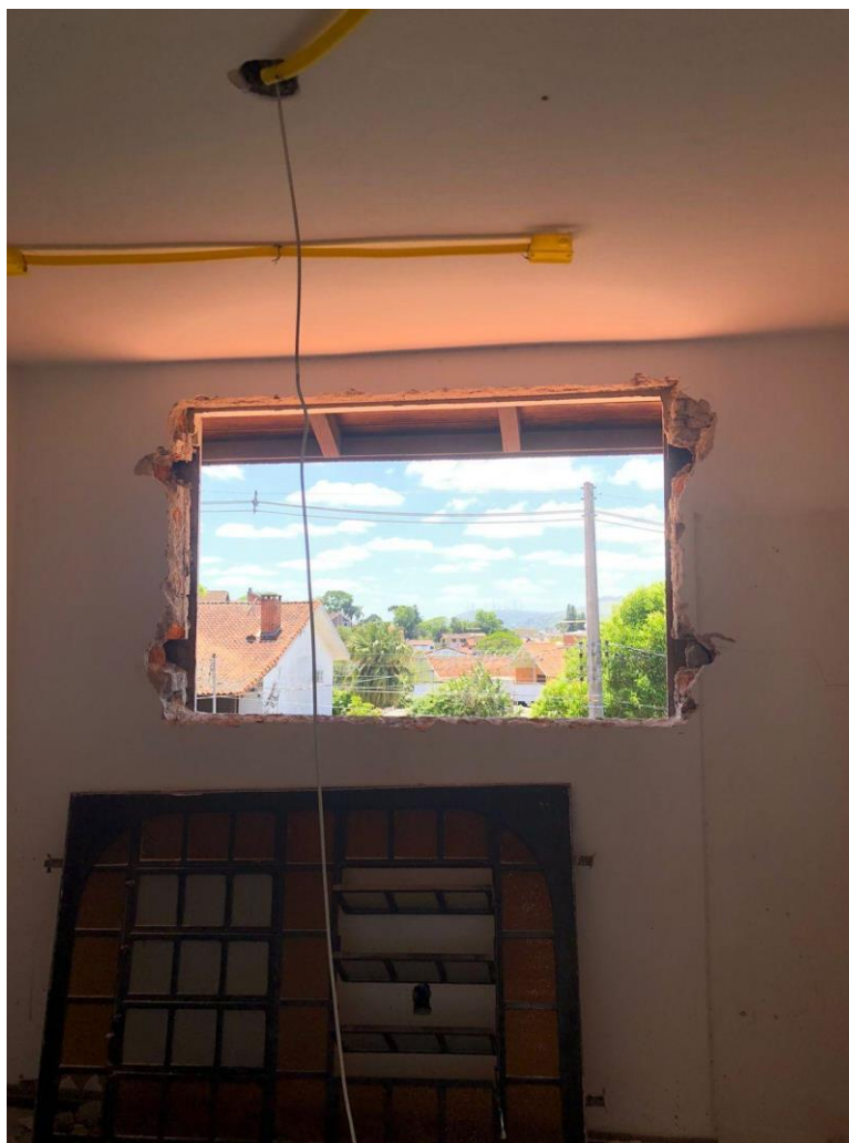
Figura 21 - Registro da etapa de remoção de esquadrias
