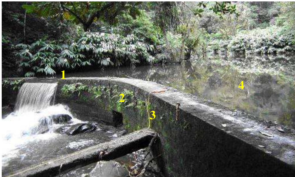
FIGURA 43 - Foto lateral da barragem da Cascata das Borboletas. (1) vertedouro; (2) descarga de fundo; (3) início da tubulação de baixa pressão; (4) área represada.
