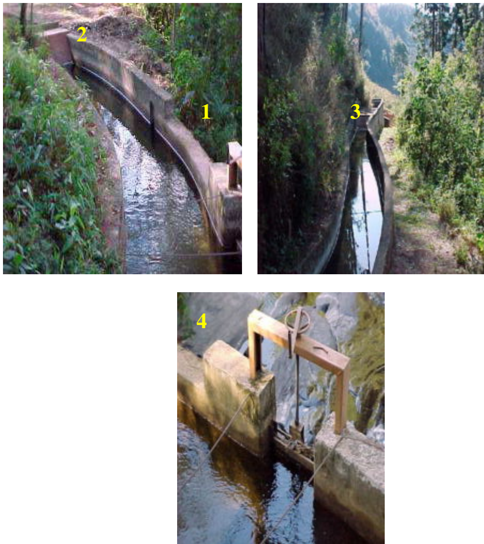
FIGURA 44 - Exemplo de canal de adução utilizado na MCH de Boa Esperança (Delfim Moreira - MG). (1) vertedor extravasor; (2) grade; (3) continuação do canal de adução; (4) comporta desarenadora lateral.
