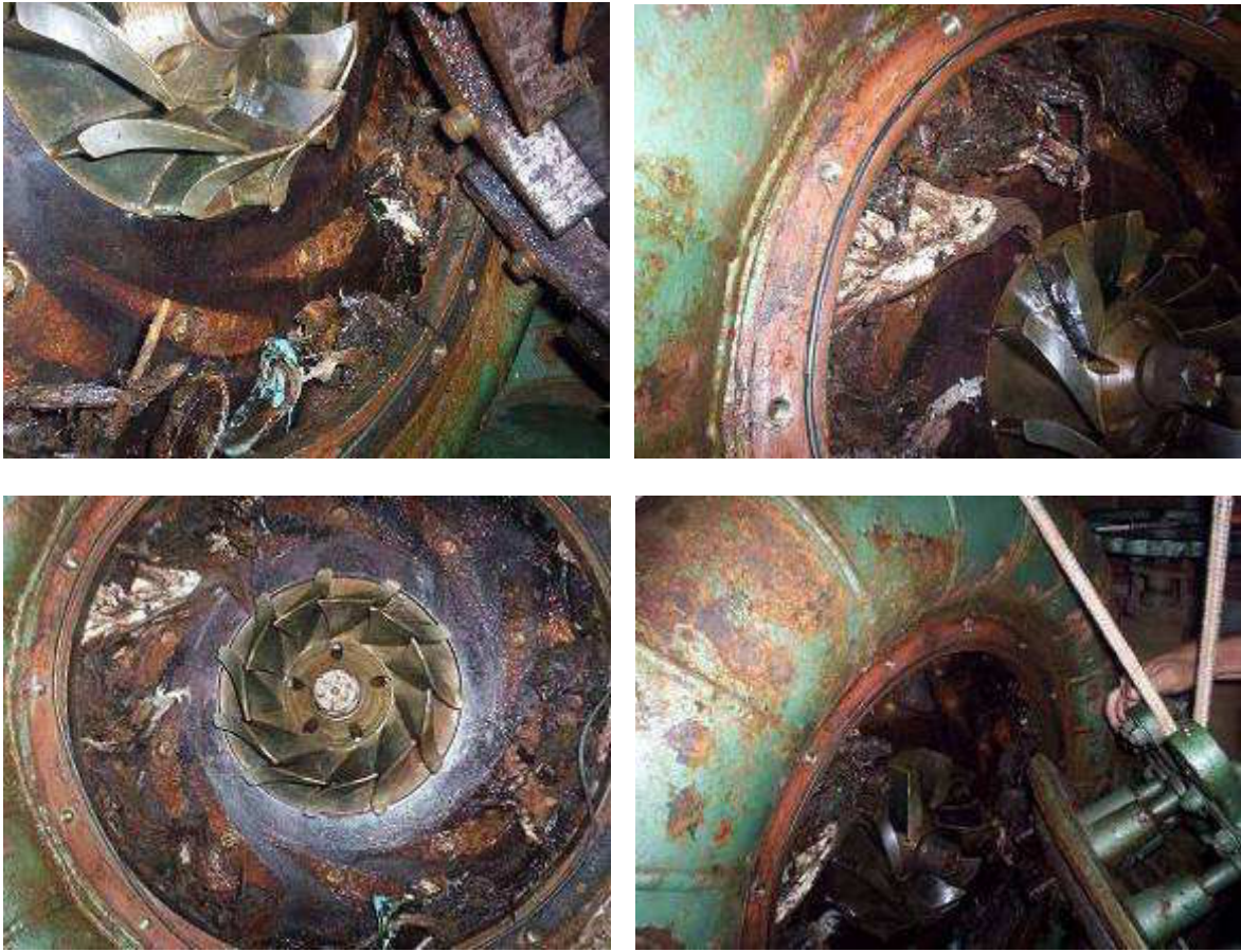
FIGURA 42 - Limpeza padrão da turbina Francis. Turbina aberta.
