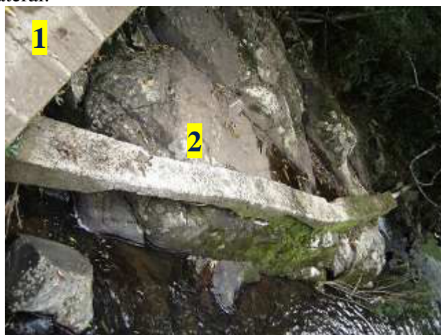
FIGURA 45 - (1) Barragem; (2) Conduto de baixa pressão. É o local onde se pretende construir o canal de adução na MCH da Ponte.
