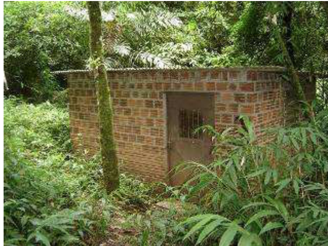
FIGURA 34 - A Casa de Máquinas da Cascata das Borboletas.
