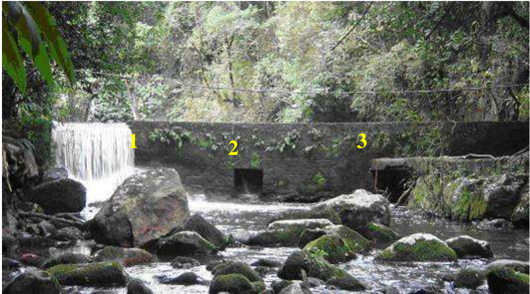
FIGURA 27 - Foto frontal da barragem tipo arco utilizada na Micro Usina da Cascata das Borboletas. (1) vertedouro; (2) descarga de fundo; (3) tubulação.
