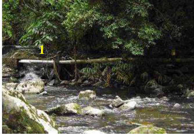
FIGURA 46 - (1) Conduto de baixa pressão. É o local onde se pretende construir o canal de adução.
