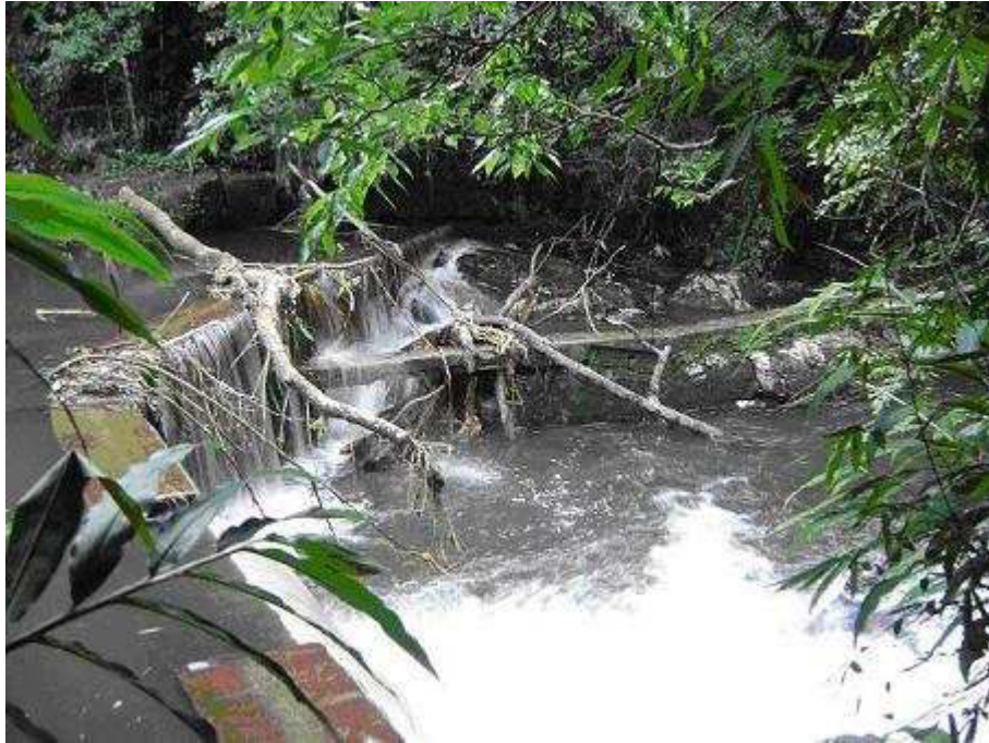
FIGURA 41 - Visão Lateral da barragem após enxurrada. Restos de galhos e troncos de árvores ficam visíveis e dificultando a entrada de água na tubulação.
