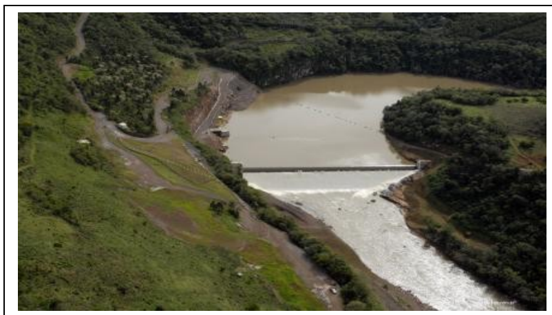
Figura 9 – Barragem da PCH Jararaca
