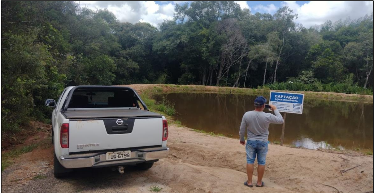
Figura 17 – Barragem de acumulação d'água (açude Linha Preta)
