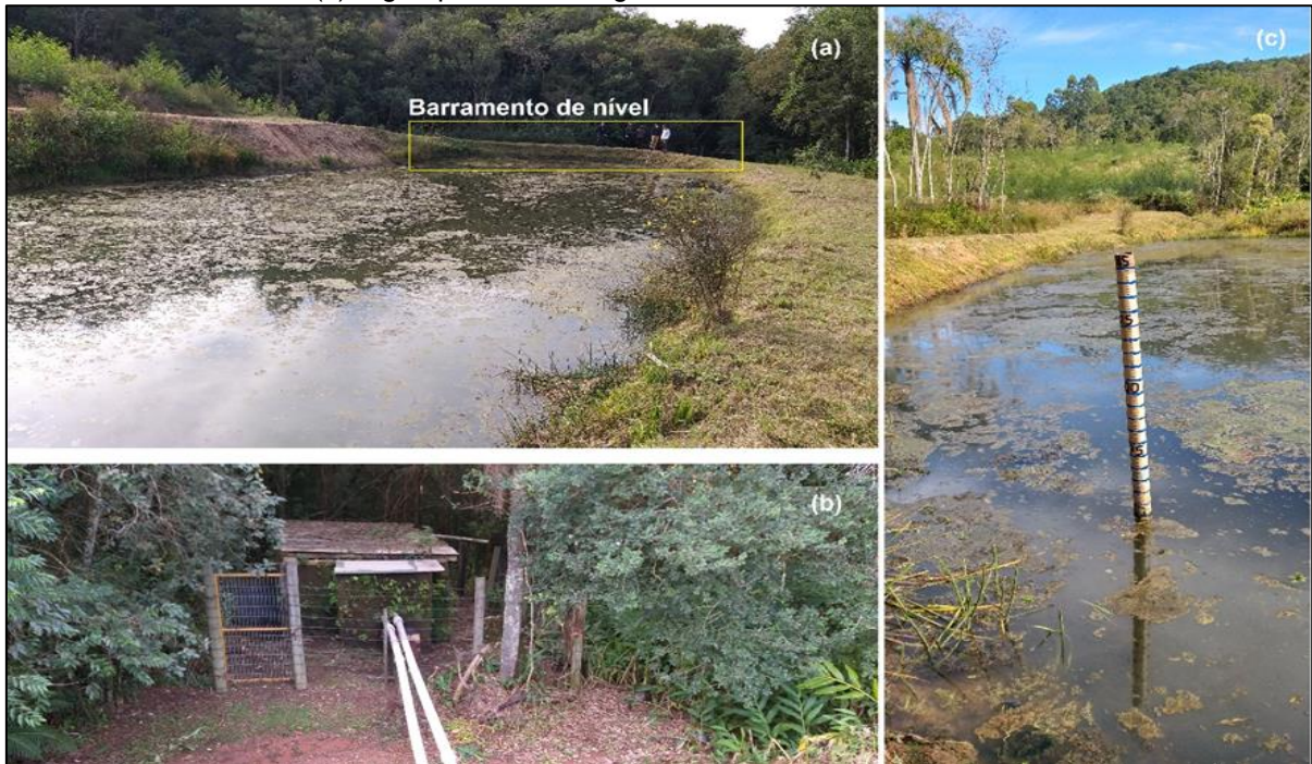
Figura 15 - Componentes do sistema de captação, (a) barramento de nível, (b) estrutura para retenção de sólidos e (c) régua para nível d'água.
