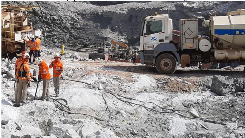
Figura 18 - Operação de carregamento da bancada a ser desmontada, realizada pela empresa Orica e equipe de desmonte da Great Panther Mining
