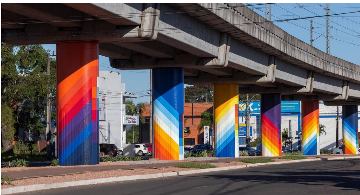
Figura 18 - Trabalho de Bruno Schilling na linha do Trensurb em Novo Hamburgo/RS.
