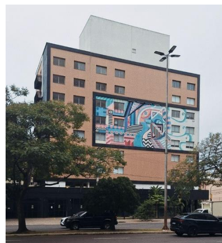
Figura 10 - Obra de Eduardo Lanna no Edifício Studio CB. Fonte: Pesquisador, 2024.
