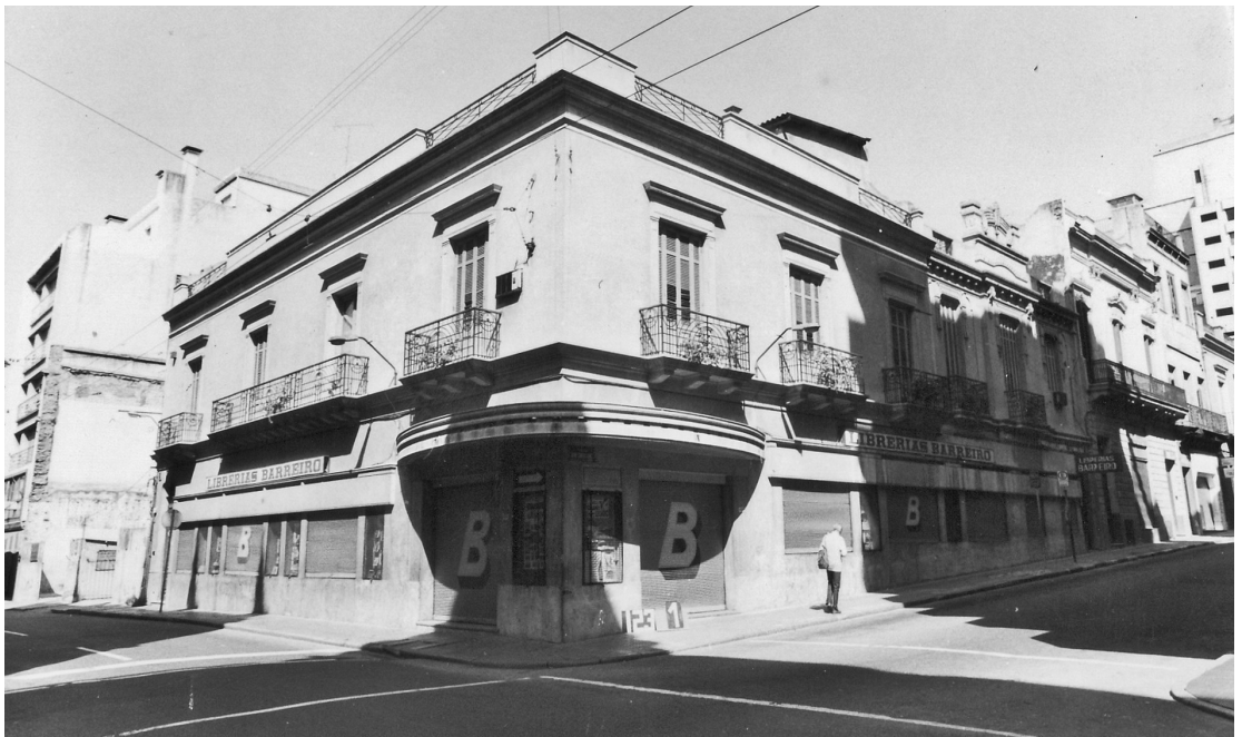
Figura 4 – Edifício Barreiro y Ramos antes da intervenção.
