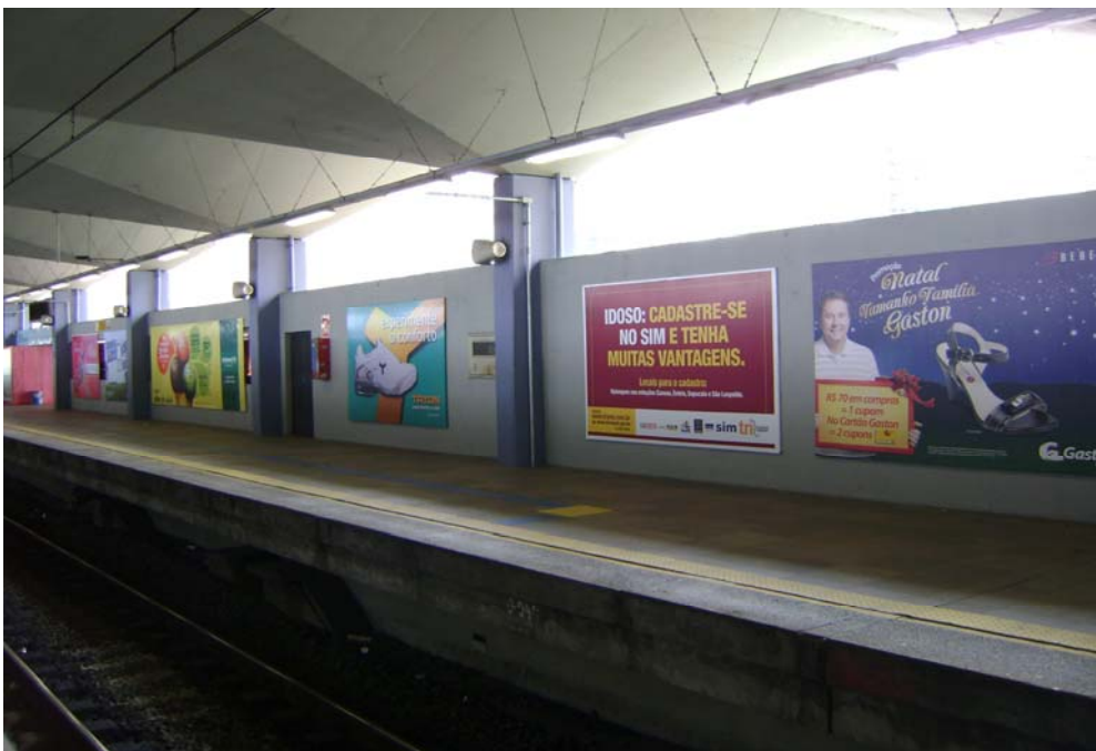
Figura 7 – Placas de publicidade no muro interno da estação Mercado
