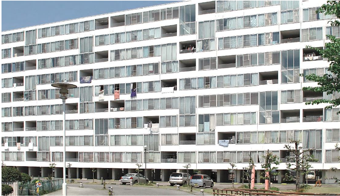
150_Trecho da fachada sul
