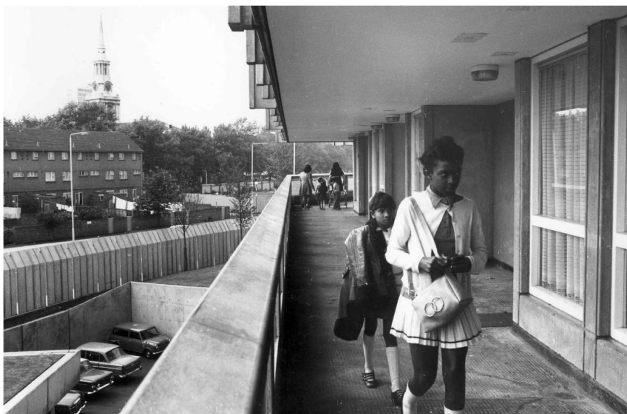
089_Deck de circulação no bloco oeste, c. 1972
