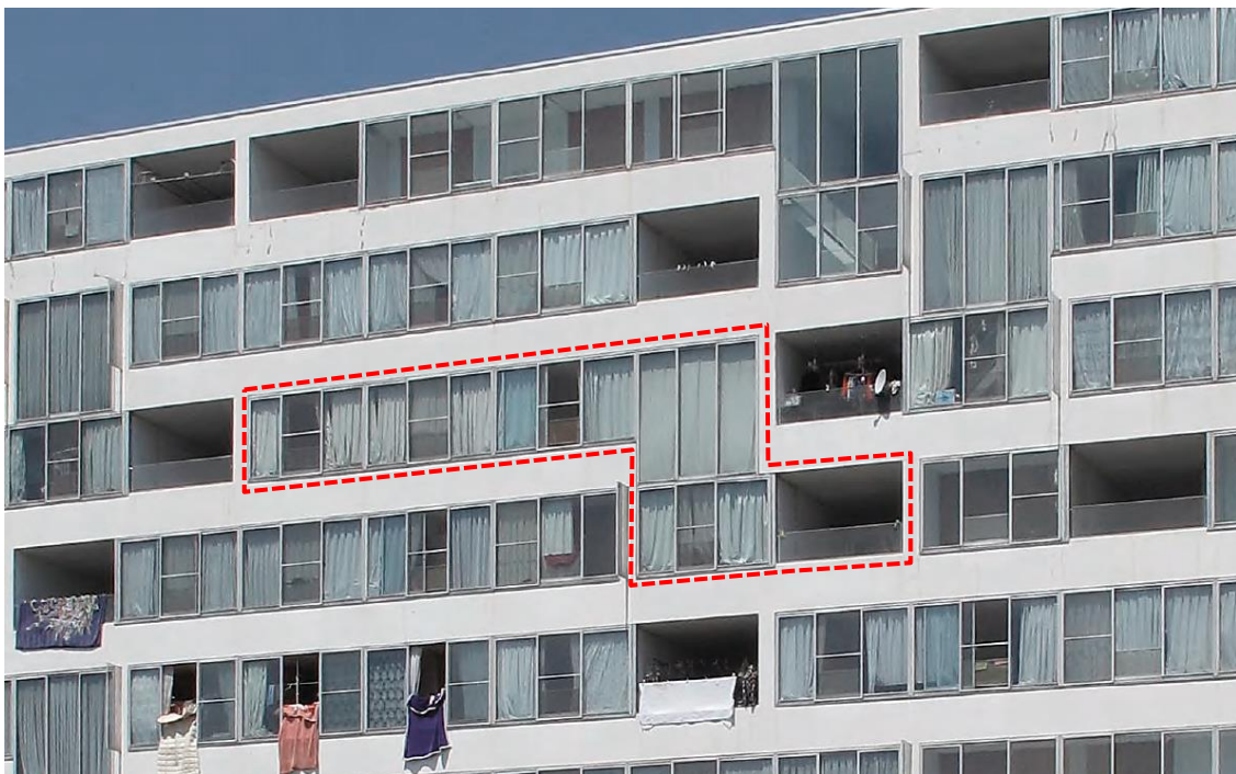
126_Trecho da fachada sul, em destaque o duplex tipo S
