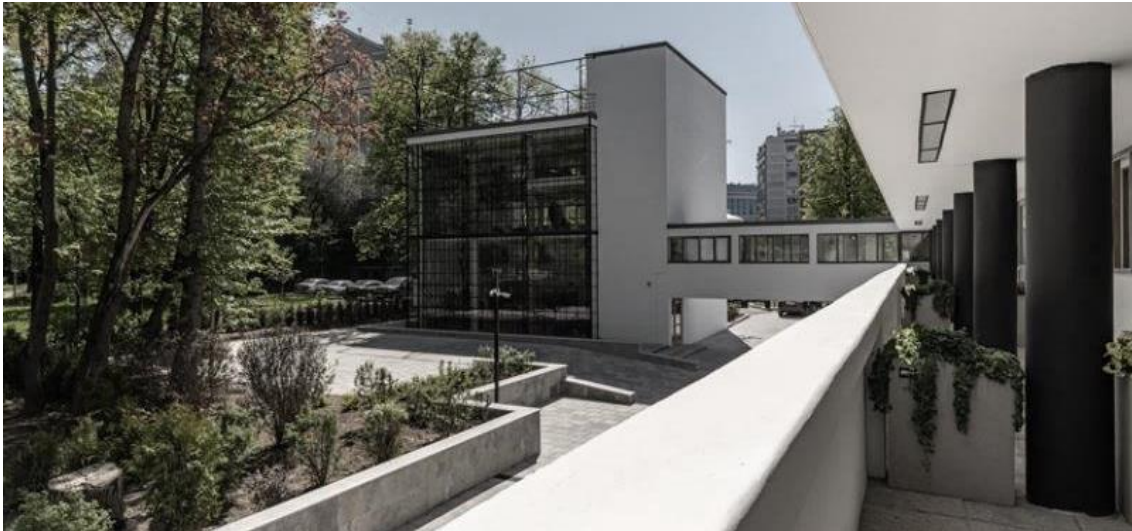
021_O bloco de serviços e a ponte de acesso vistos desde a sacada junto do corredor Fonte: http://architecture-history.org/index.html
