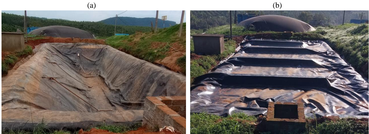
Figura 3.3 - (a) Canadense aberto, sem alimentação; (b) Canadense fechado, com alimentação.
