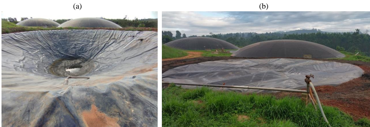
Figura 3.5 - (a) CSTR aberto, sem alimentação; (b) CSTR fechado, com alimentação.
