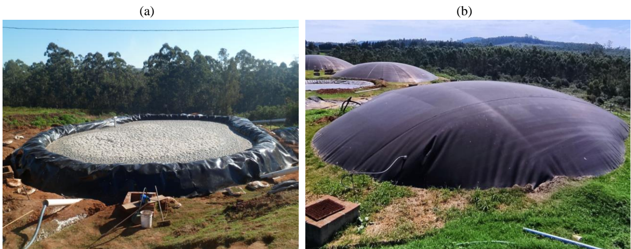
Figura 3.4 - (a) Fluxo ascendente, aberto e inoculado; (b) Fluxo ascendente fechado, com alimentação.
