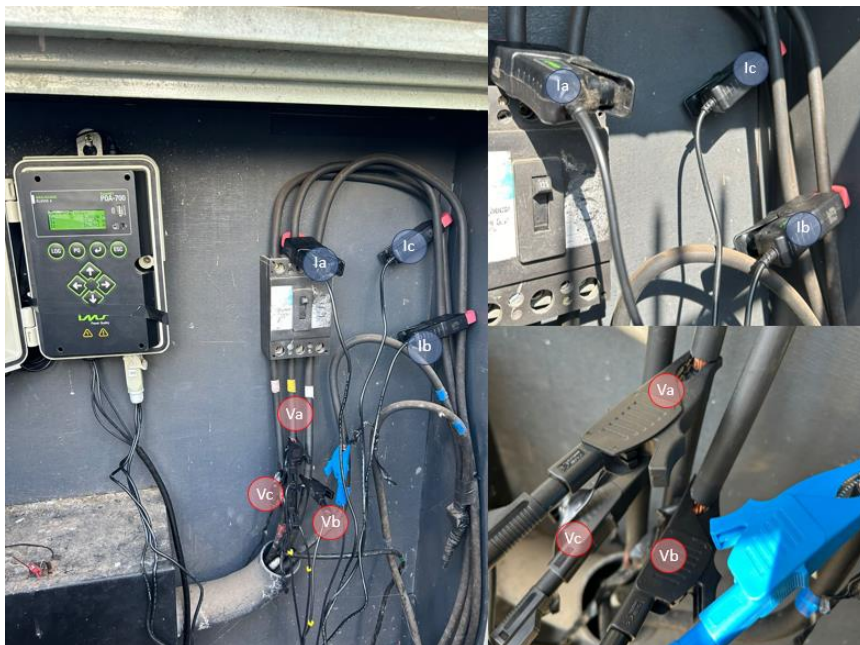
Figura 20 – Medições realizadas na fábrica Monta Brasil.
