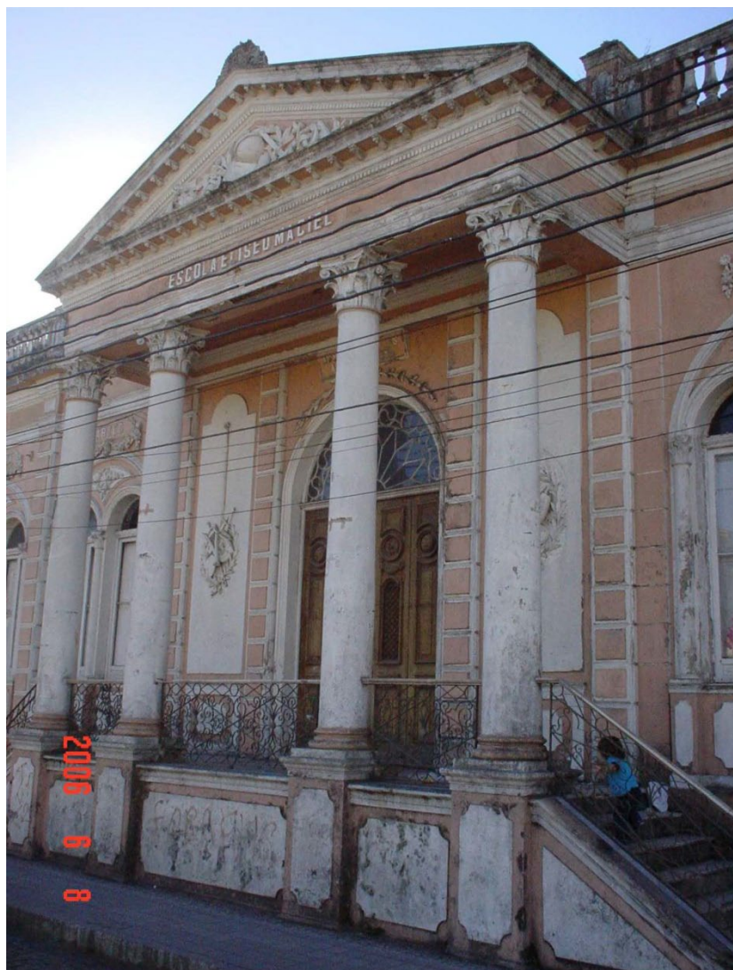
Figura 7 – Detalhe da fachada da Escola antes do restauro
