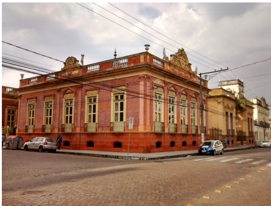
Figura 4 – Vista do conjunto tombado pelo IPHAN, do qual faz parte o Casarão 8 (em primeiro plano)
