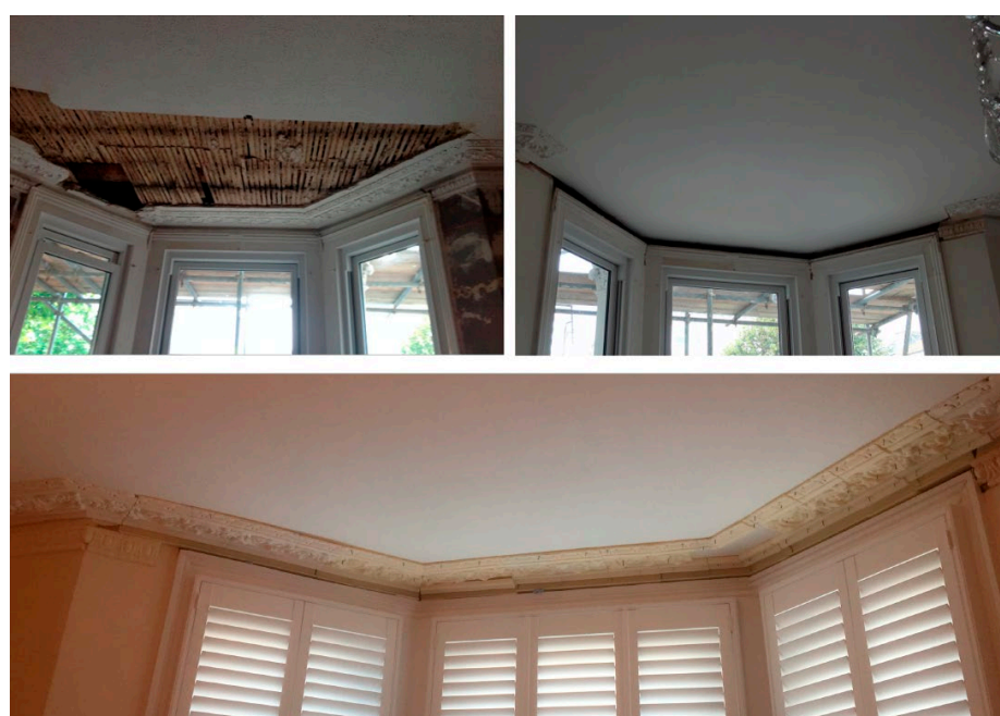
Figura 19 – Forro e ornatos antes do restauro (à esquerda), forro preenchido sem os ornamentos (à direita) e restauro finalizado (base da figura)
