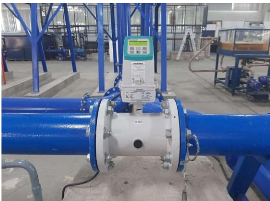
Figura 4-20: Medidor e transmissor eletromagnético de vazão de água.
