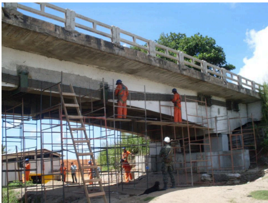
Figura 2 – Reforço em ponte com protensão externa
