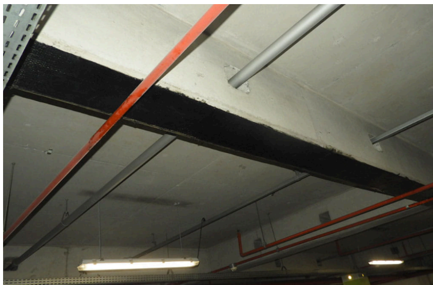
Figura 5 – Reforço estrutural em viga com fibra de carbono
