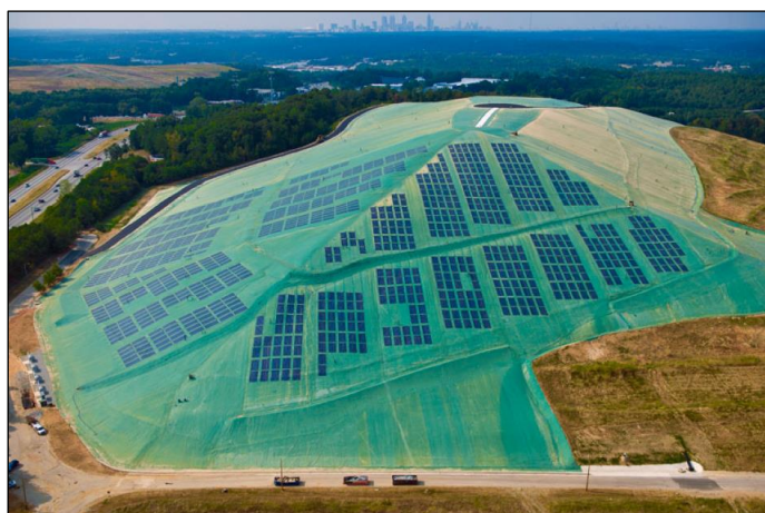
Figura 16: Aterro sanitário de Hickory Ridge (EUA) com cobertura de geomembrana solar.
