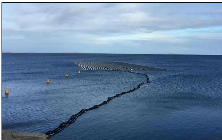
Figura 17: Usina solar flutuante instalada no Reservatório de Sobradinho, na Bahia.
