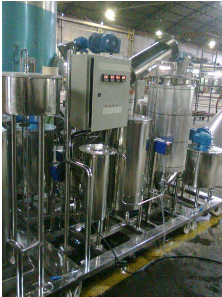
Instalação do sistema elétrico para operação da planta piloto.
