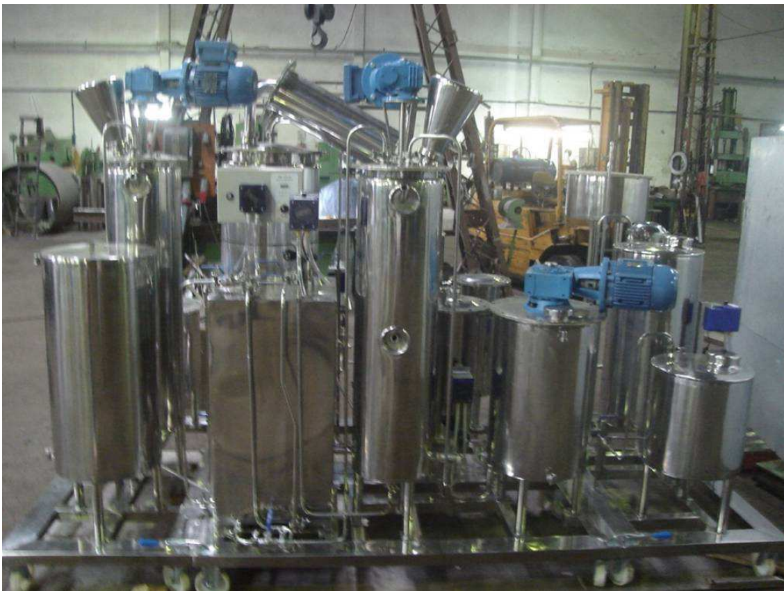
Planta piloto montada após a colocação de tubulações, válvulas, bombas e agitadores.
