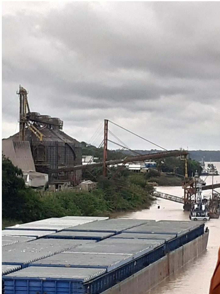
Figura 3 – Terminal de transbordo da Cargill e balsa graneleira no rio Madeira, Porto Velho
