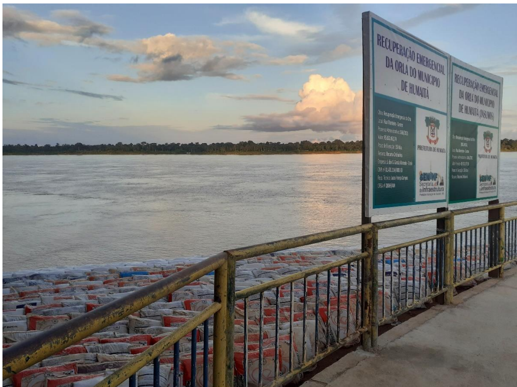
Figura 5 – Orla de Humaitá em obra de recuperação emergencial
