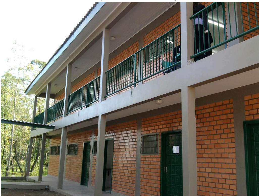
FIGURA 2 - Prédio de Salas de aula (EMEF Áurea Celi Barbosa)
