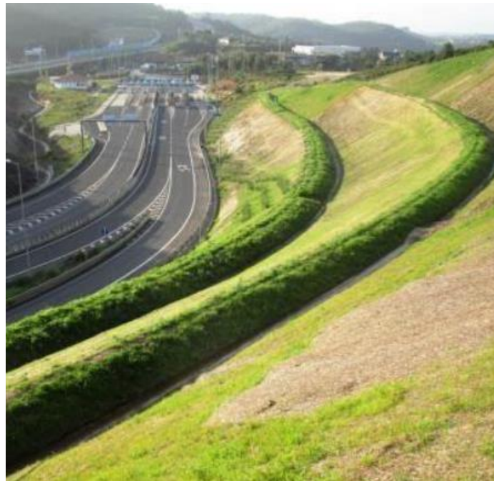
Figura 94 – Talude de Corte
