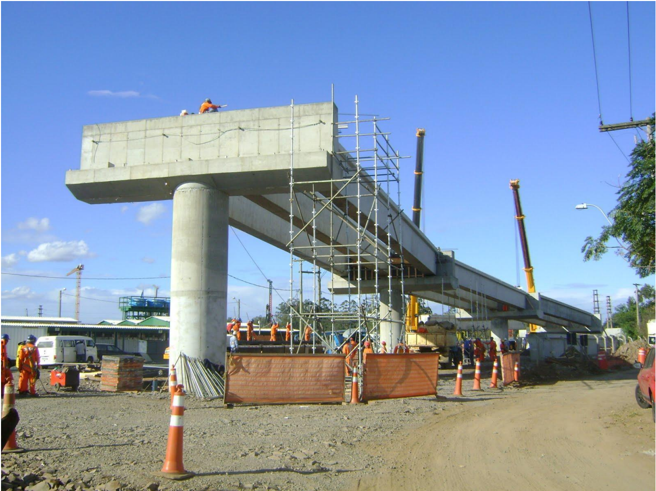
Figura 82 – Construção do viaduto da BR-448 sobre a BR-290
