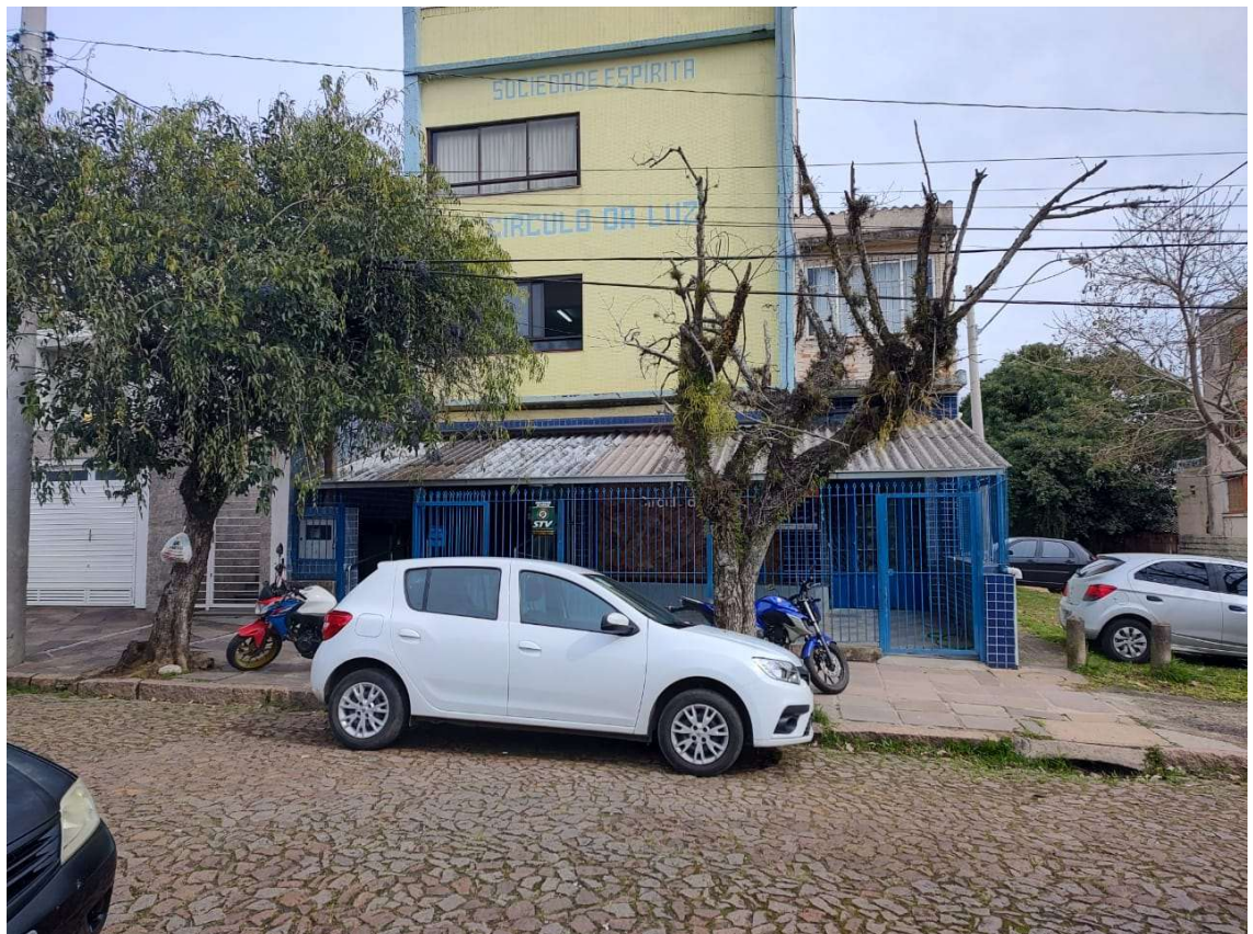
Figura 1 - Fachada do Edifício
