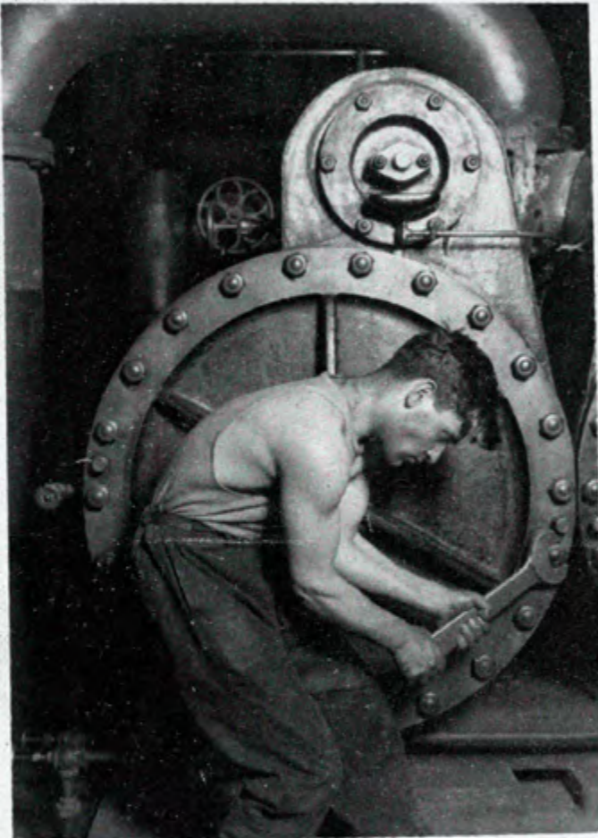
Mecânico da casa de força trabalhando na válvula de vapor Lewis Hine fotografia 1920
