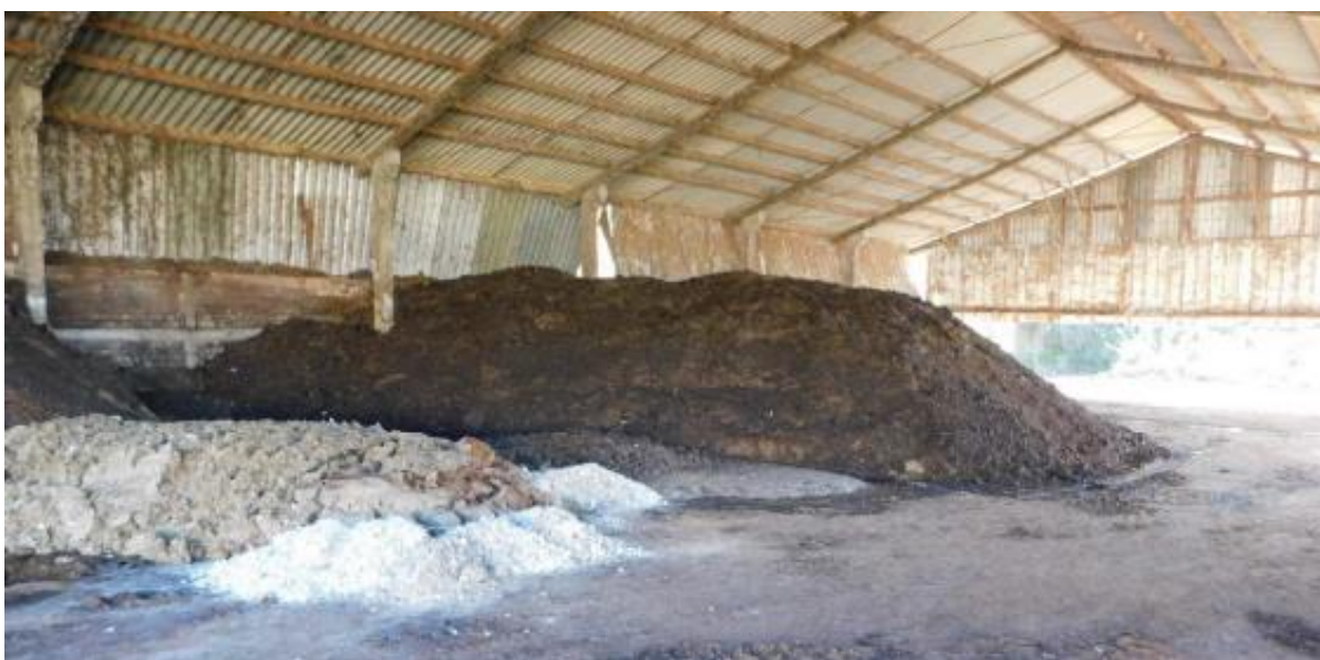
Figura 6 - Galpão de estocagem de resíduos
