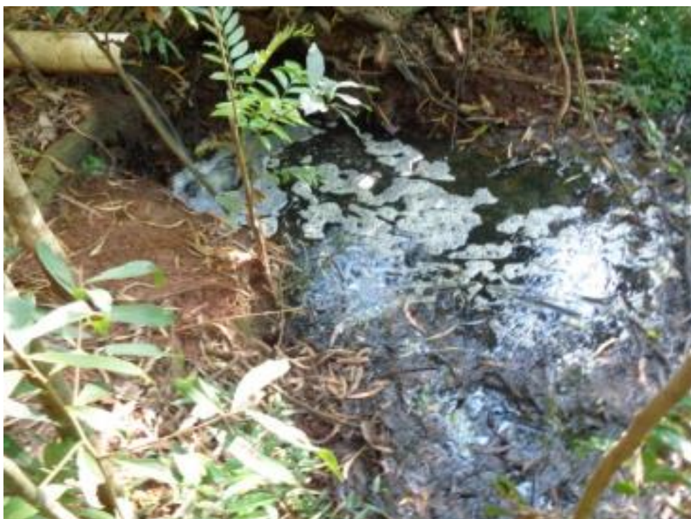
Figura 24 - Lançamento de Efluentes Líquidos irregular
