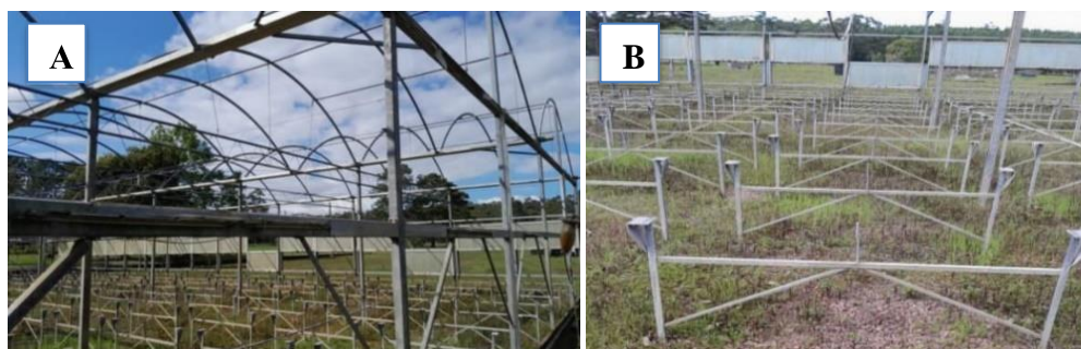
Figura 7: Estufa inativa na qual foi realizado o projeto para reforma e reinstalação para viveiro de produção de mudas florestais em propriedade rural visitada durante o estágio, na região da PCE do Rio Grande do Sul. A) Estrutura da estufa; B) Bancadas para produção de mudas.
