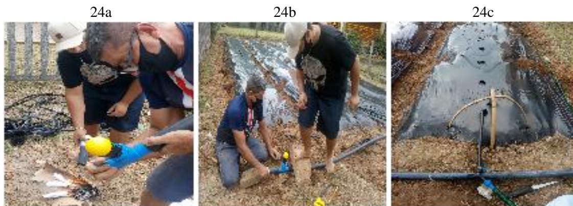
Figura 24 - Procedimentos de conexões dos canos para irrigação das mudas.
