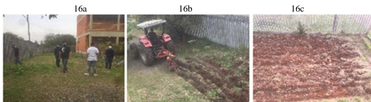
Figura 16 - Limpeza e discagem do terreno.
