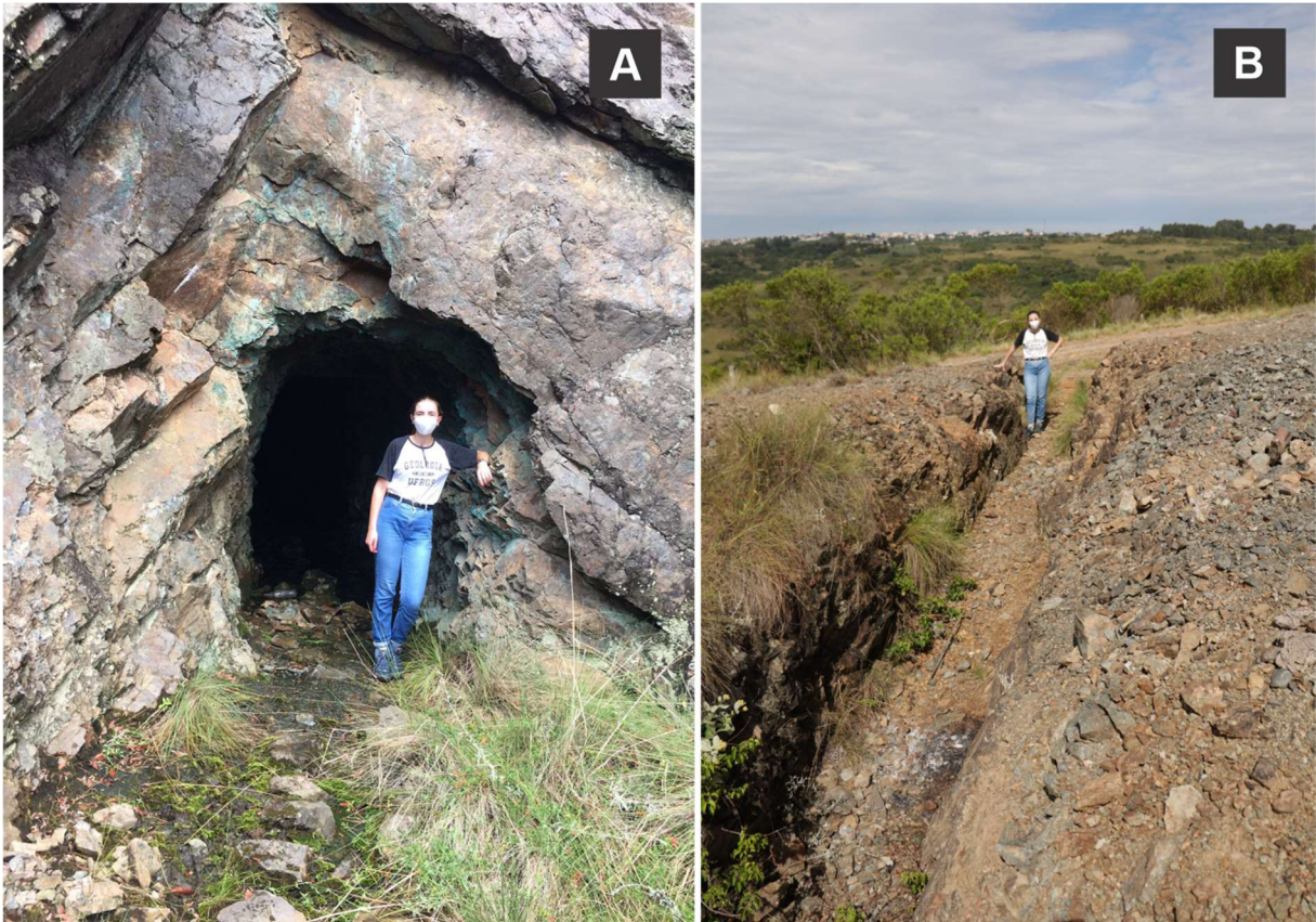
Figura 12 – Fase de campo realizada na Mina Andrade. A) Antigo túnel de prospecção mineral da mina com aproximadamente 2 m de altura, 1,5 m de largura e 25 m de comprimento. B) Trincheira localizada na superfície do depósito com aproximadamente 0,7 m de altura, 0,5 m de largura e 30 m de comprimento. Fonte: Elaborada pela autora.
