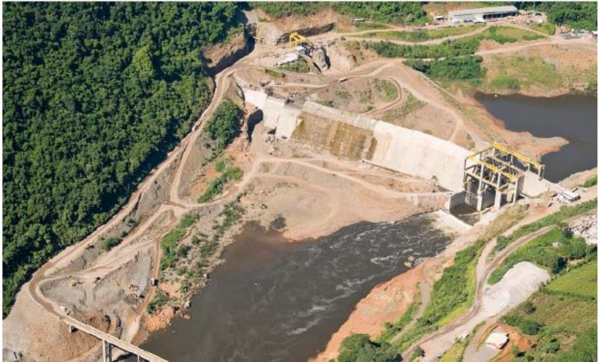
Figura 12. Vista aérea da UHE 14 de Julho. Fonte: Fernandes et al. (2008).
