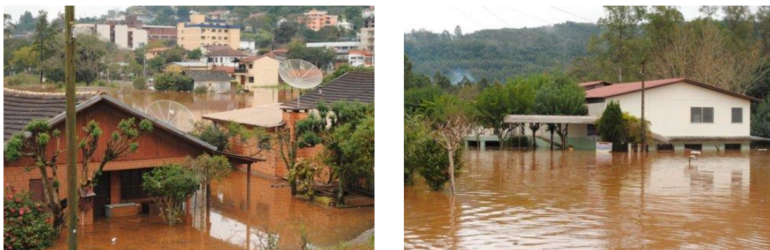
Figuras 2 e 3. Inundação em julho de 2011, município de Encantado - RS. 1
