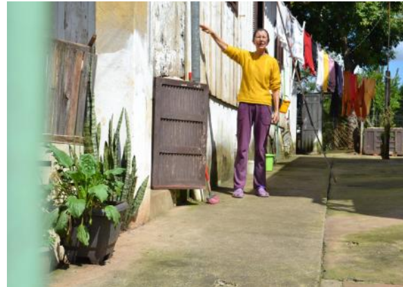
Figura 71 - Marcas da inundação que atingiu o município em 2001.
