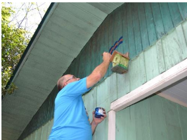
Figura 35 - Demarcação do nível da inundação que atingiu o telhado da moradia.
