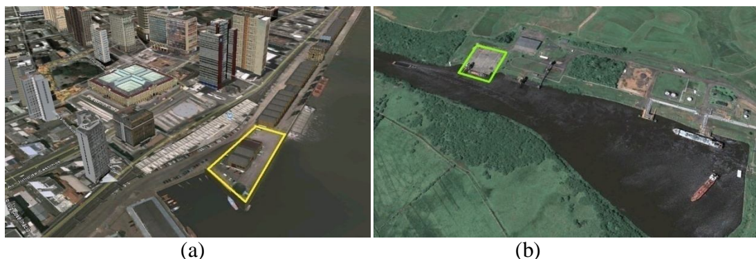
Figura 5: (a) Cais B3, porto de Porto Alegre, (b) Terminal de containeres, porto de Santa Clara. (Fonte: Google Earth 2010)
