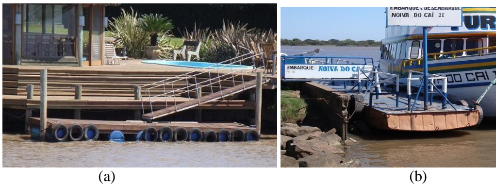
Figura 10 – (a) Plataforma Flutuante de madeira sobre cilindros plásticos, (b) Plataforma flutuante de aço (Fonte: Próprio autor, Rio Guaíba 2010)
