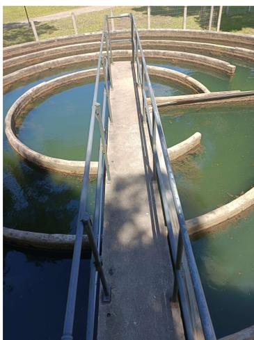
Figura 2: Imagem do tanque decantador da estação de tratamento de água da empresa TDK Electronics do Brasil Ltda.
