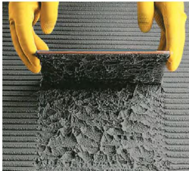
Figura 12 - Verificação de aderência da argamassa colante em peças cerâmicas
