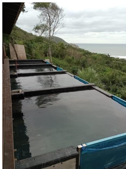
Figura 39 - Teste de estanqueidade simultâneo das quatro piscinas
