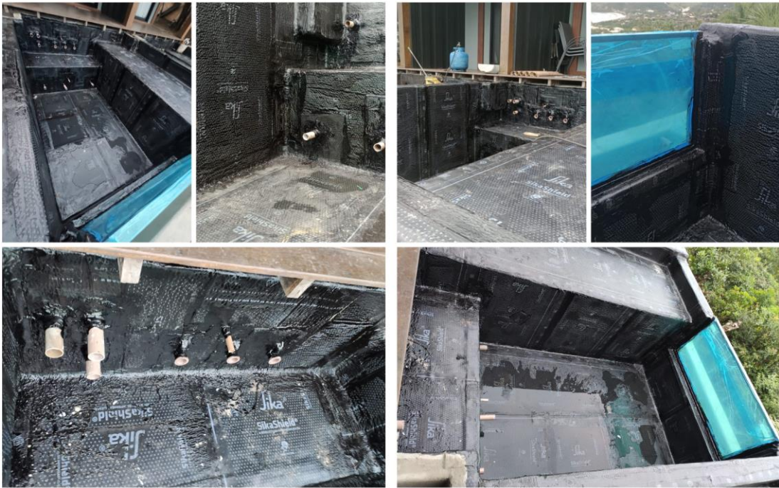
Figura 38 - Diversas imagens do sistema de impermeabilização finalizado
