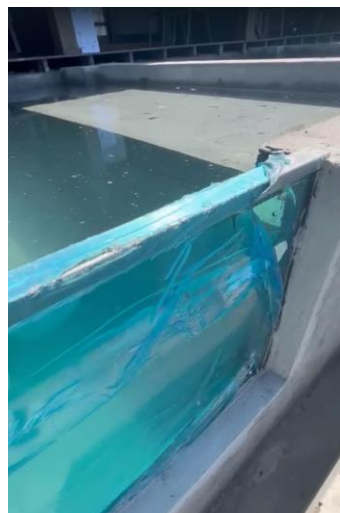
Figura 43 - Teste de estanqueidade após conclusão do revestimento de argamassa
