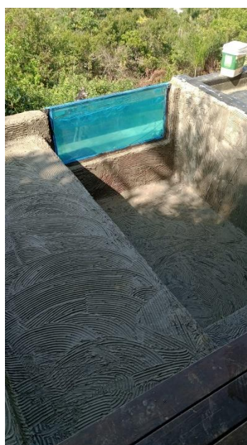
Figura 41 - Aplicação de argamassa chapisco colante com desempenadeira dentada
