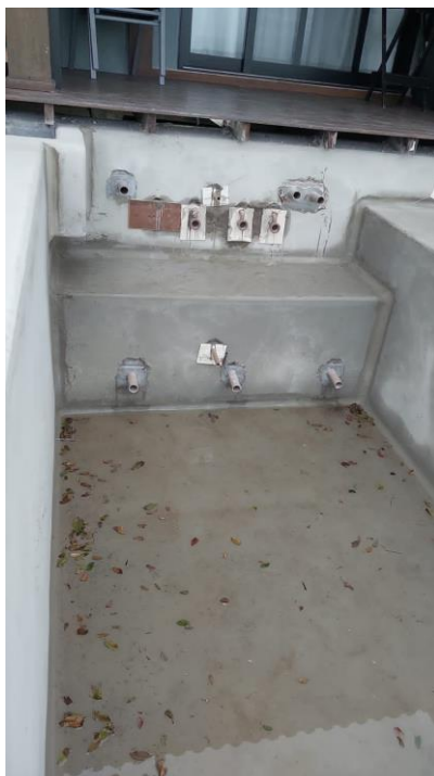
Figura 35 - Chumbação das tubulações emergentes de PVC
