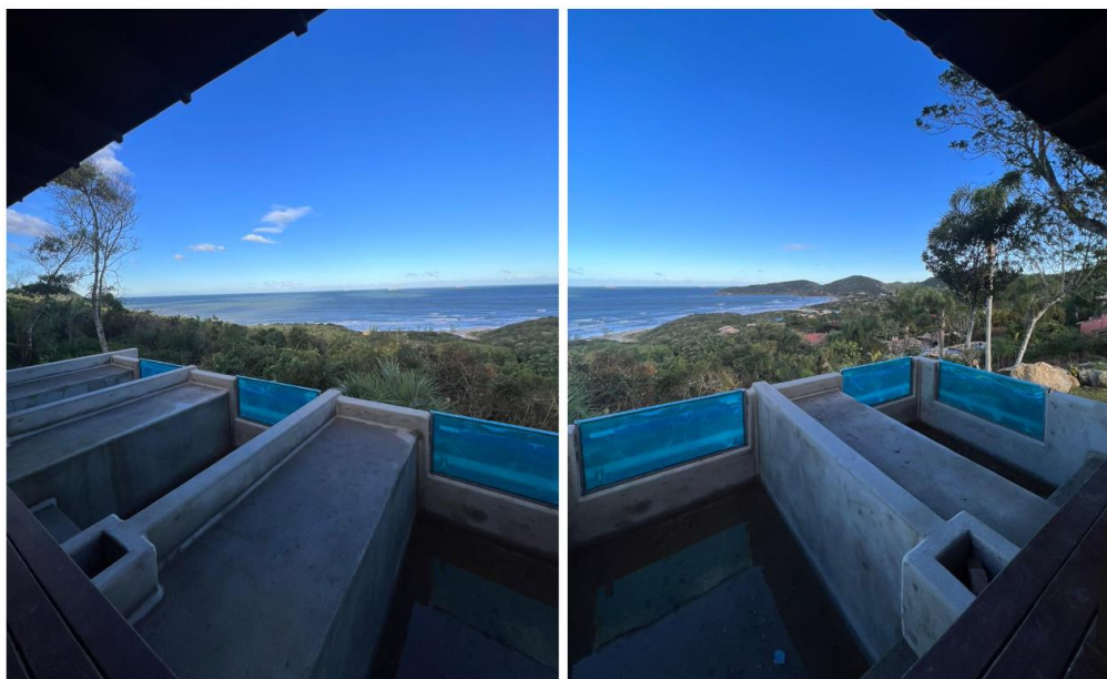
Figura 36 - Paredes estruturais de vidro instaladas nas estruturas regularizadas
