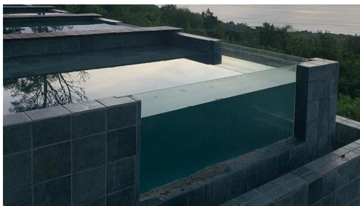
Figura 31 - Paredes estruturais de vidro instaladas
