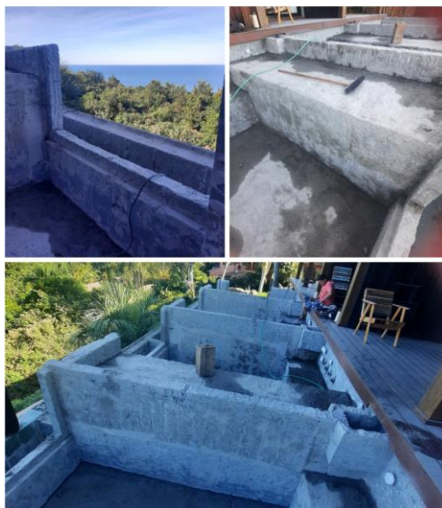
Figura 32 - Piscinas sem revestimentos
