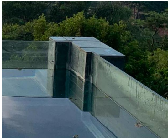
Figura 53 - Instalação das paredes estruturais de vidro
