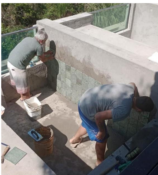
Figura 44 - Execução do assentamento das pastilhas cerâmicas
