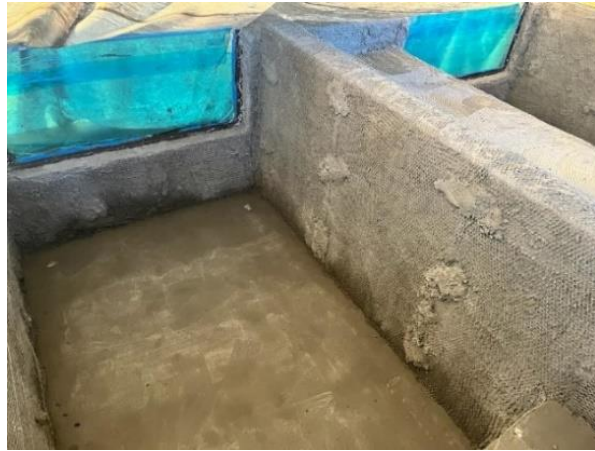
Figura 42 - Instalação de tela hexagonal nas paredes das piscinas
