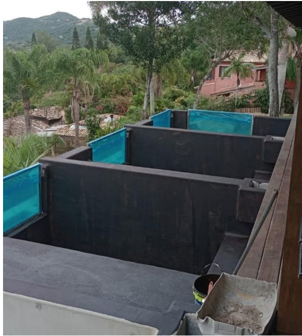
Figura 37 - Estrutura regularizada com aplicação de primer para imprimação
