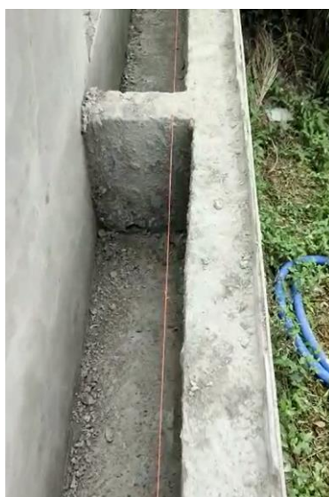
Figura 51 - Linha de nivelamento do revestimento de argamassa
