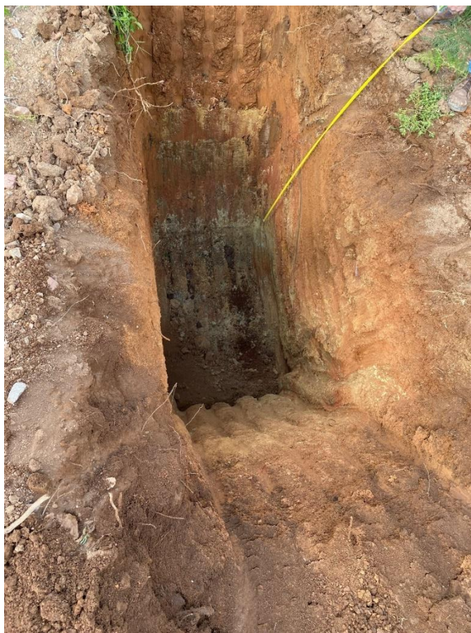
Figura 16: trincheira de inspeção da fundação (Autor, 2023).
