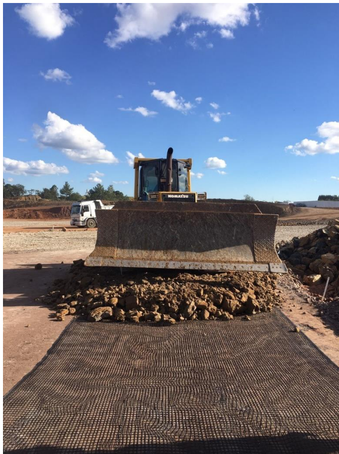
Figura 20: pista teste para verificação de danos ao reforço (Autor, 2023).
