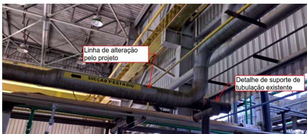
Anexo III – Figura (b) – Imagem de scanner 3D onde aparece o encaminhamento da linha onde será o tie-in e possíveis pontos de suportaço
