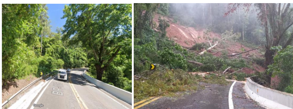
Figura 13 - Deslizamento de encosta BR 116 km 181.
