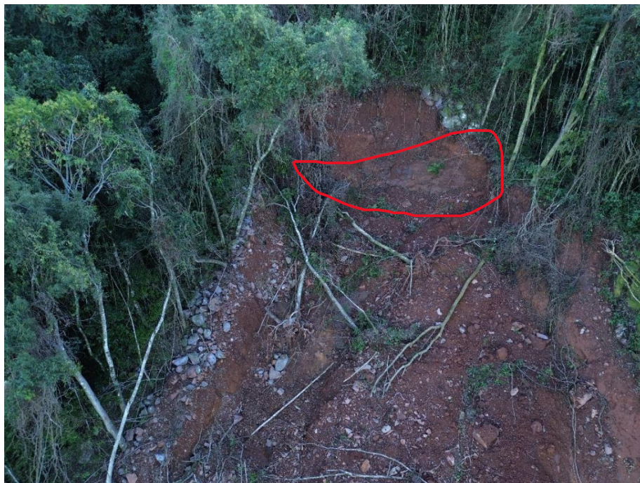
Figura 16 - Escarpa do talude e afloramento do horizonte rochoso
