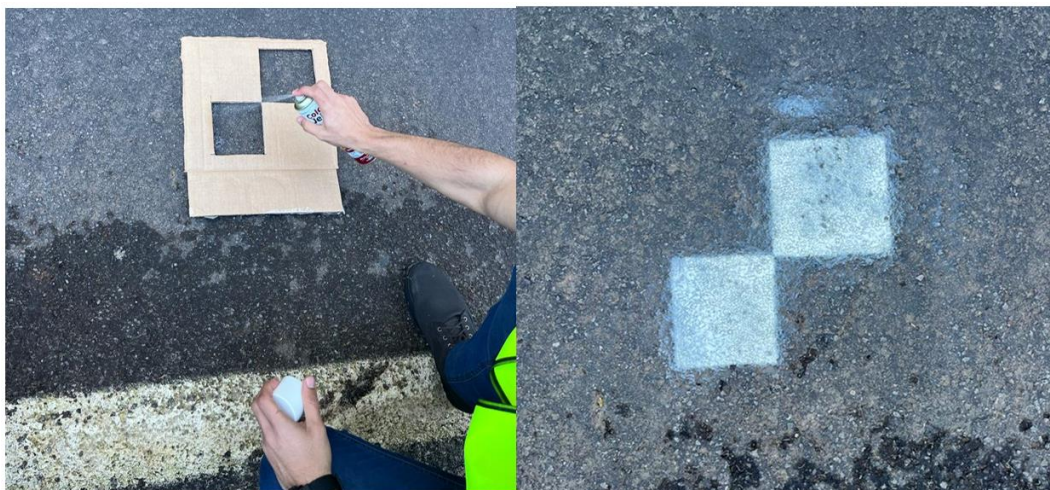
Figura 11 - Pintura das grades de controle.
