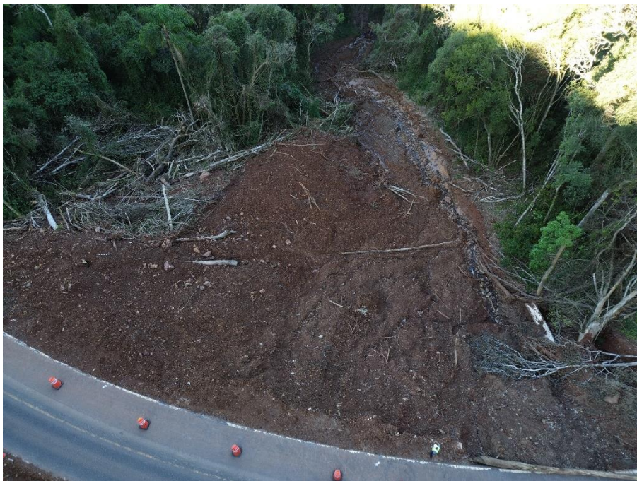
Figura 21 - Parte inferior do deslizamento
