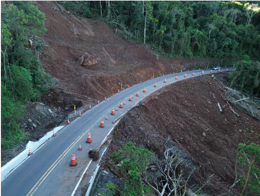
Figura 20 - Vista lateral do talude
