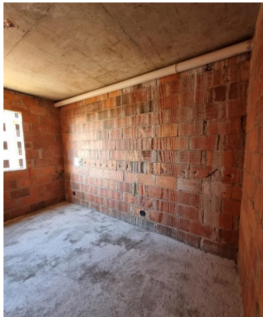
Figura 44 – Registro da parede A252
