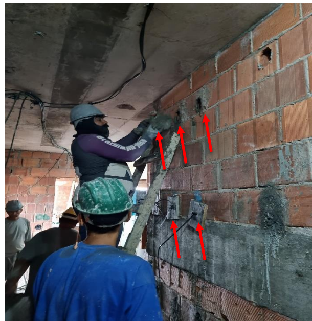
Figura 38 – Execução dos pontos de graute de reforço estrutural – Térreo, Torre C.
