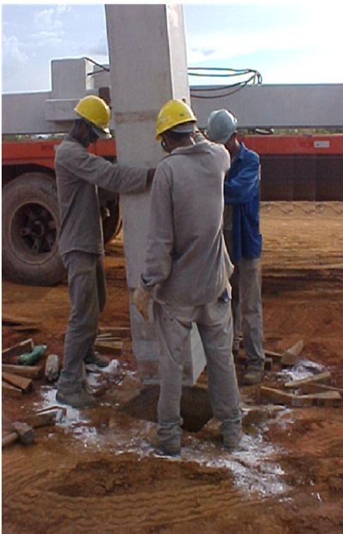
O quadro de montagem dos pilares é executado no fundo dos blocos nivelados, e têm como finalidade, facilitar a montagem, permitindo que a tolerância de posicionamento, prumo e rotação, sejam mais facilmente respeitadas. O quadro de montagem é feito da seguinte maneira:
