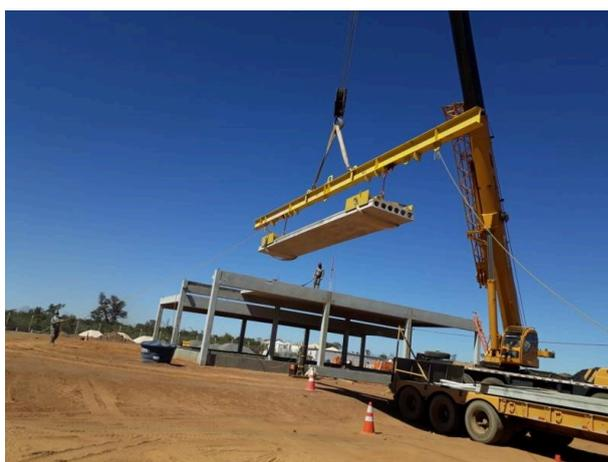
Figura 5 - Içamento de um módulo de laje alveolar (Fonte: Site IBPC/distribuição gratuita, 2024)
