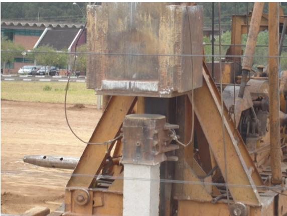
Após cravada a estaca, deve-se preparar a cabeça da mesma de acordo com as condições de projeto e execução:
