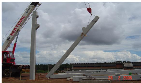
A montagem da estrutura deve ser conduzida de modo a obedecer as tolerâncias especificadas para a fundação e superestrutura. Como no
