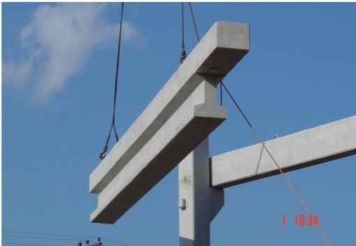
As vigas são montadas sempre sobre aparelhos de apoio com base em neoprene nas duas extremidades, com especificação e dimensões definidas em projeto. Não é permitida a colocação de dois aparelhos de apoio sobrepostos. O aparelho de apoio deve estar rigorosamente centrado, tanto nos apoios das vigas quanto nos consolos dos pilares.
