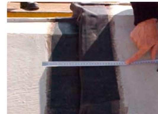
Protótipo – observe o degrau no topo da viga e a junta esponjosa entre as telhas.
