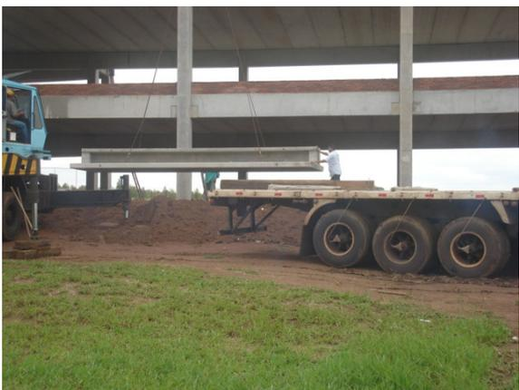
Antes de descarregar a peça do veículo de transporte, todos os cintos, laços, alças, e proteção nos cantos dos elementos devem ser cuidadosamente removidos. Laços, alças e tiras não devem ser removidos a menos que a estabilidade da peça esteja assegurada. Se cintos forem utilizados para o descarregamento, materiais de proteção deverão ser utilizados onde houver contato destes com as peças, para minimizar danos.
