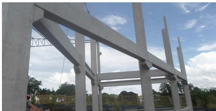
Figura 3 - Modelo de vigas pré-fabricadas (Fonte: Construtora estilo/distribuição gratuita, 2024)
