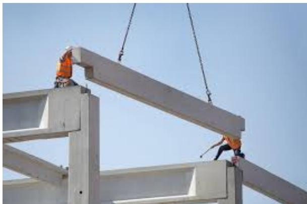
Figura 30 - Montagem de viga pré-fabricada (Fonte: manual da ABCIC/distribuição livre)
