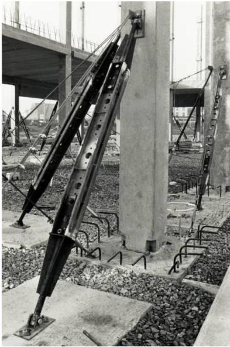
A conferência dos níveis das bases dos pilares deve ser executada antes da colocação dos mesmos, com utilização de aparelho de nível ou mangueira d'água e de acordo com os dados do Esquema de Montagem. Caso necessário, o ajuste do nível deve ser executado com a utilização de argamassa de cimento.
