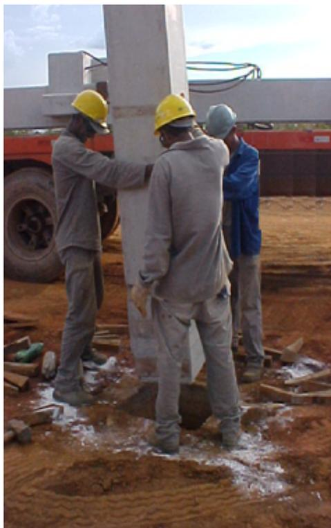
Figura 28 - Montagem do pilar no bloco de fundação. (Fonte: manual da ABCIC/distribuição livre)
