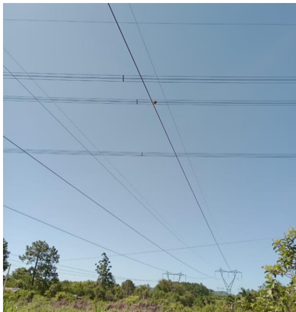
Figura 11 – Fotografia da travessia das linhas de transmissão de 525 kV e 230 kV.
