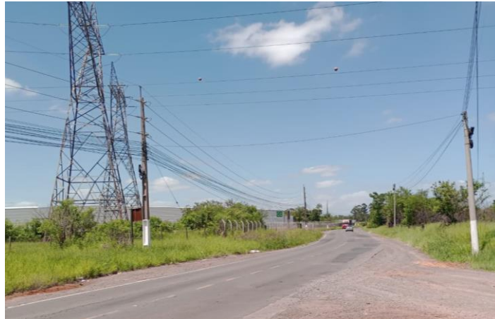
Figura 17 – Fotografia da travessia da linha de transmissão de 230 kV e linha de distribuição de 23 kV.
