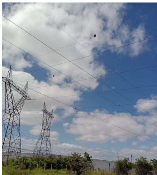
Figura 14 – Fotografia da travessia das linhas de transmissão de 230 kV e 138 kV.
