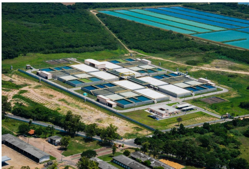
Figura 4 - Estação de Tratamento de Esgoto Serraria, Porto Alegre/RS
