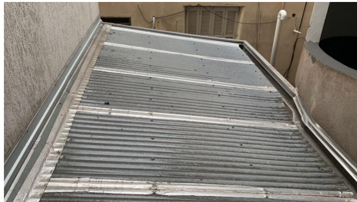
Figura 25 – Reparos de funilaria e impermeabilização feitos no telhado do mercado
