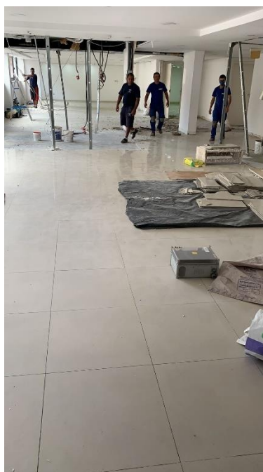
Figura 69 – Piso existente sem proteção, podendo ser danificado com a obra
