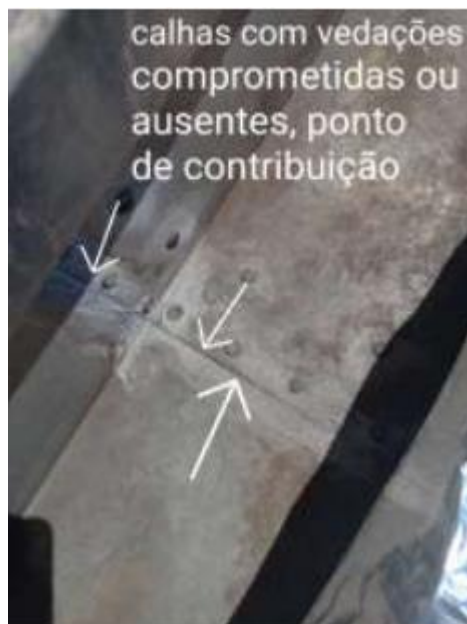
Figura 39 – Pontos de contribuição na calha
