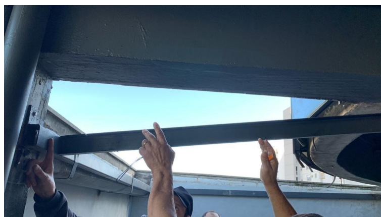
Figura 80 – Serralheiros adaptando a estrutura, com o telhado metálico já removido
