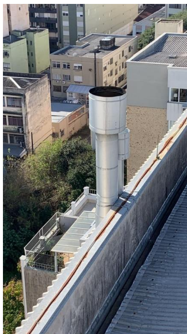
Figura 56 – Chaminé com chapéu corrigido de diâmetro 50cm
