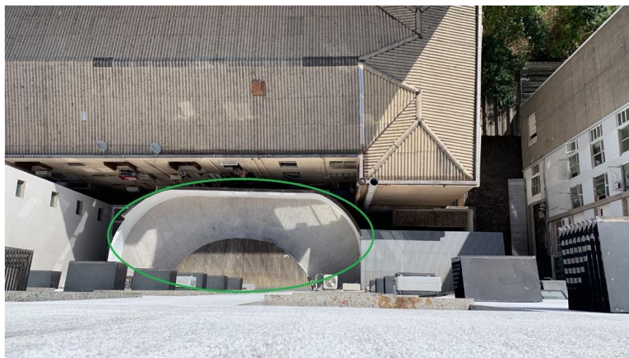
Figura 54 – Rampa do estacionamento usada para subir as peças, vista de cima
