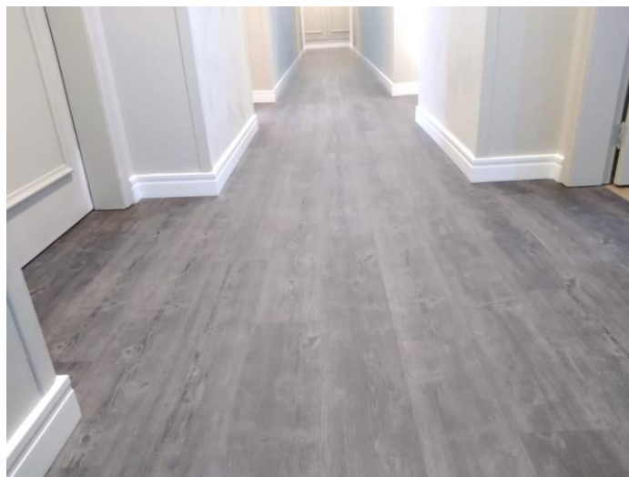
Figura 61 – Primeiro pavimento tipo executado com a instalação de piso vinílico concluída
