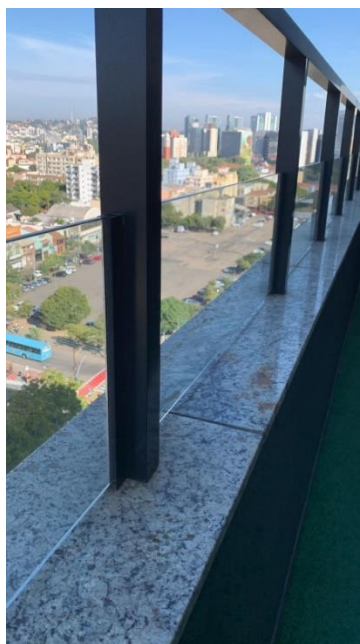
Figura 51 – Vidros fixados no guarda-corpo após o retrofit
