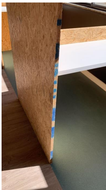
Figura 75 – Peças de divisórias em madeira OSB sem acabamento
