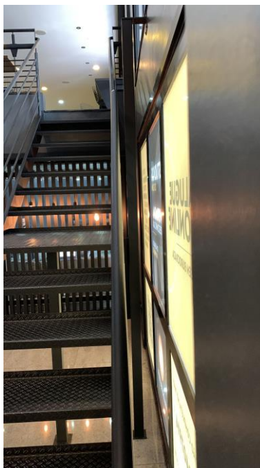
Figura 18 – Detalhes dos reparos: pilar central no patamar e pilar lateral ancorado na parede
