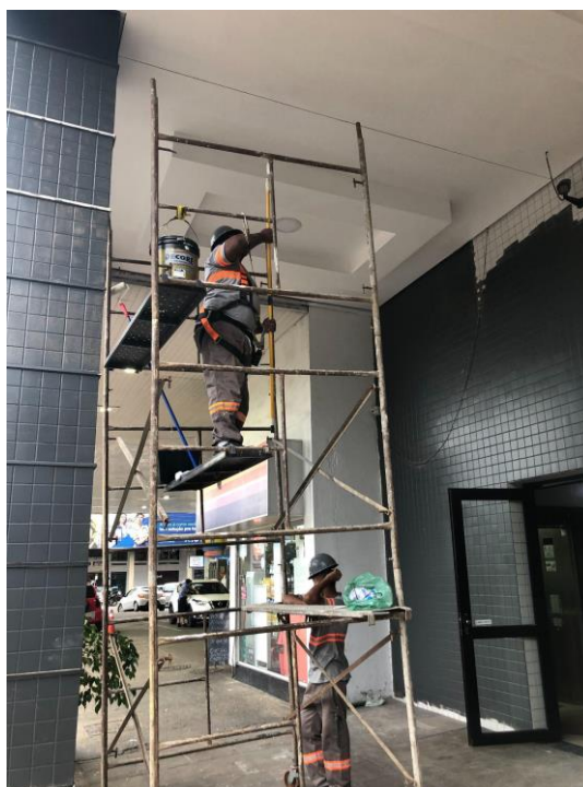
Figura 11 – Funcionários com EPI, após o remanejamento entre as equipes
