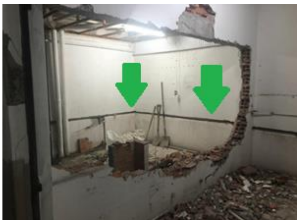
Figura 22 – Tubulação de água fria indicada sendo instalada no início da obra no térreo
