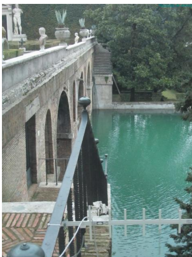
Figura 51: Escada ao tanque de peixes Fonte: AVARIIS (2012)
