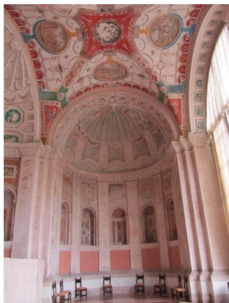
Figura 55: Pintura da loggia Fonte: AVARIIS (2012)
