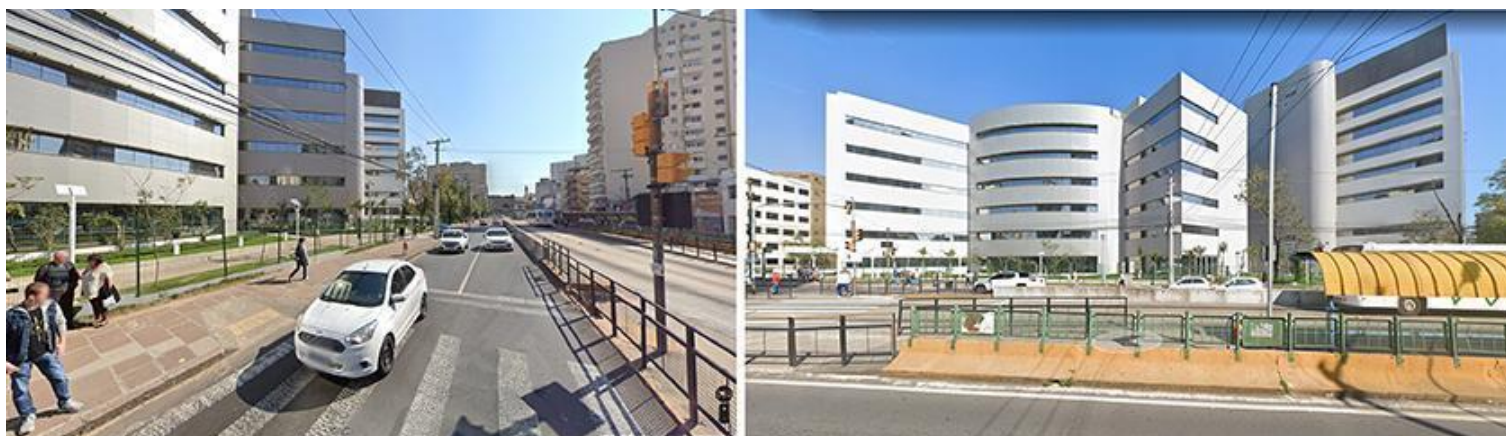
Fig. 14: Hospital de Clínicas de Porto Alegre. Vistas desde a avenida Protásio Alves. Fonte: Google Maps, 2020.
