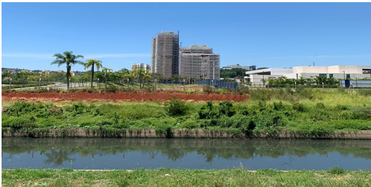
Figura 20 - Seção transversal, ao centro torres em construção
