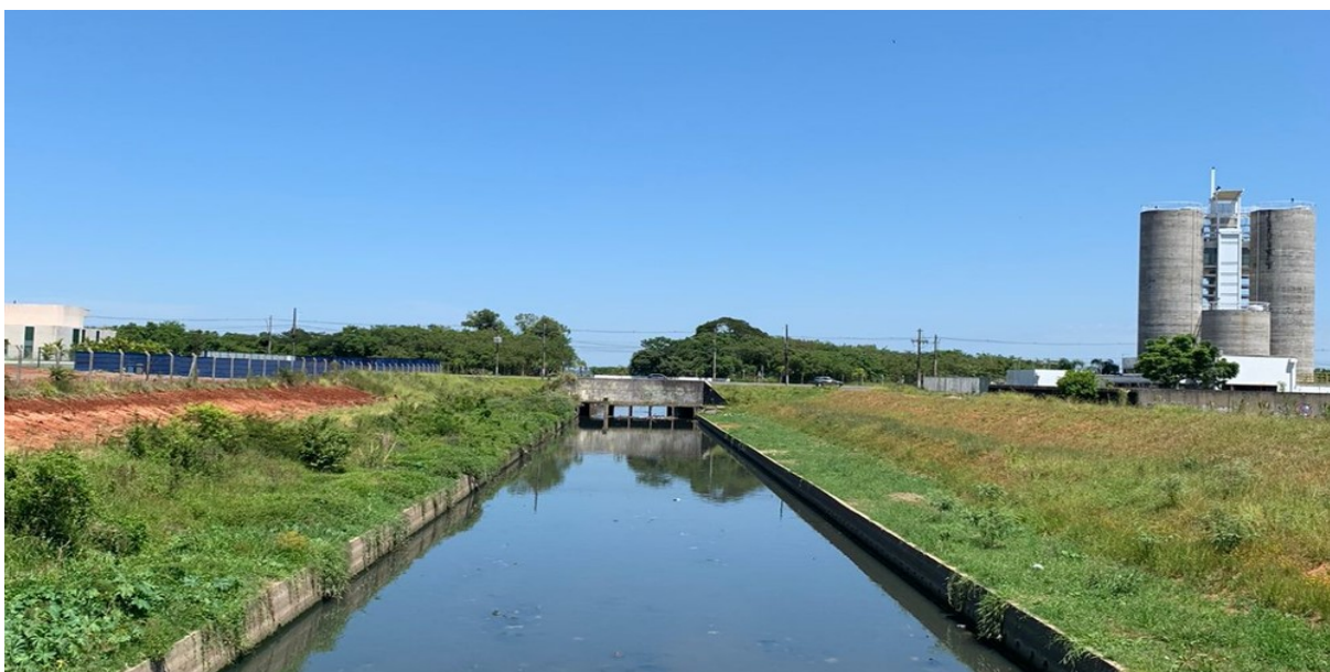
Figura 23 - Montante para jusante, vista desde a av. Pedro Américo Leal
