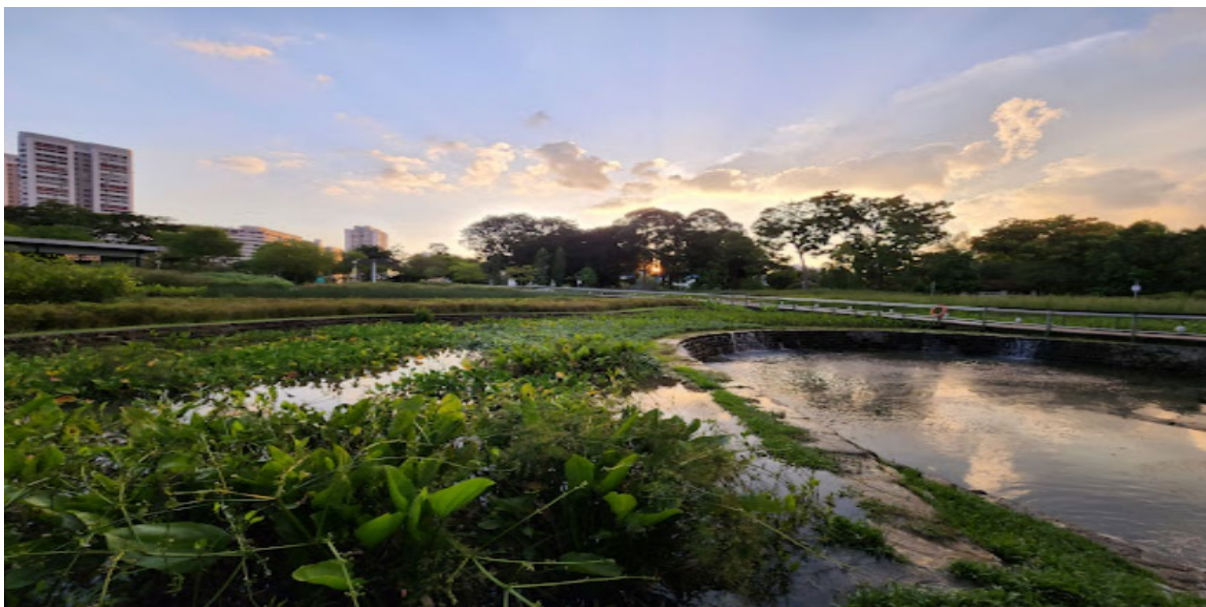
Figura 15 - Sistema de banhados construídos
