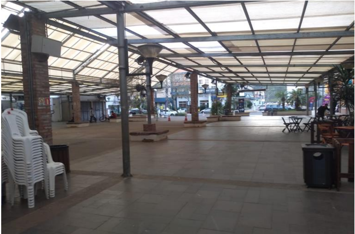
Fotografia 2 – Fundos da Biblioteca: Rua coberta
