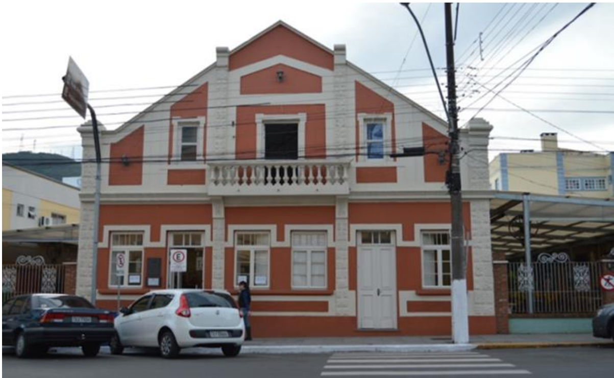
Fotografia 1 – Fachada do prédio da Biblioteca
