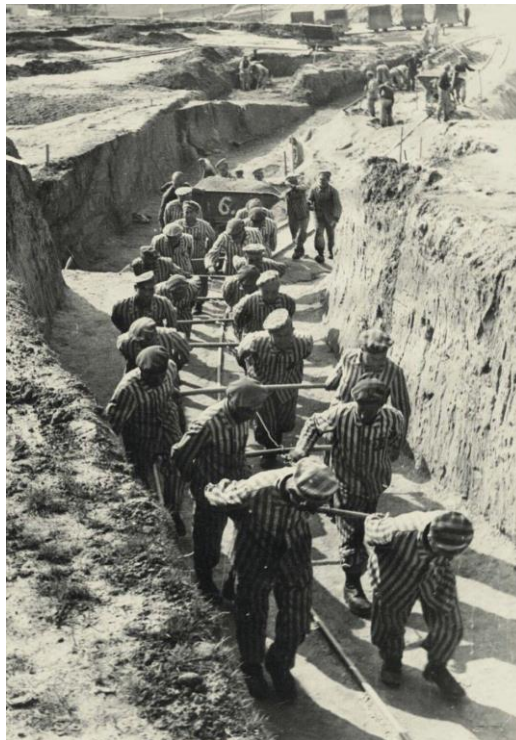
Figura 18 - Prisioneiros são forçados a trabalhar na construção de valas, 1942
