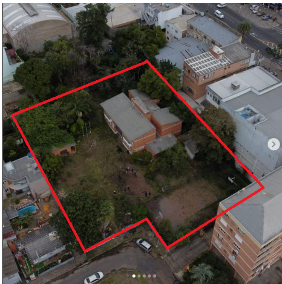
Figura 04 - Imagem da área do terreno do MUCHRS antes da reforma
