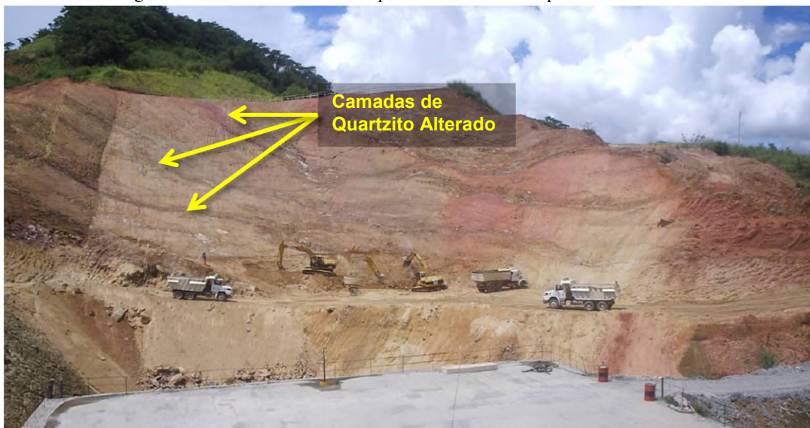
Figura 19 – Vista da Ombreira Esquerda mostrando a sequência de materiais
