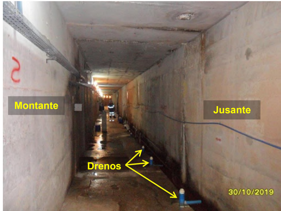
Figura 16 – Galeria de drenagem da barragem do Ribeirão João Leite – Bloco 17
