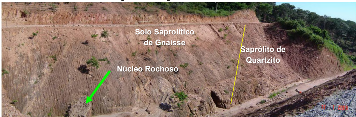
Figura 17 – Vista da Ombreira Direita mostrando o contato entre saprólito de quartzito e solo saprolítico de gnaisse com alguns núcleos rochosos
