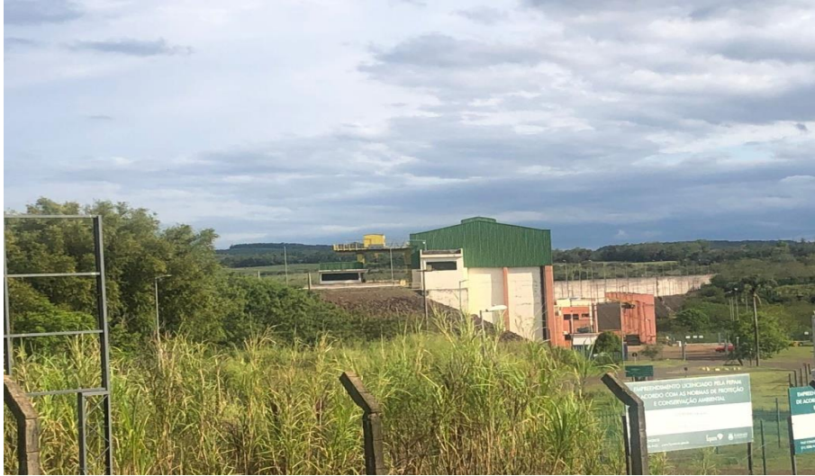
Figura 8: Estrutura da barragem artificial da UHE São José na localidade na Linha São José, interior de Salvador das Missões.
