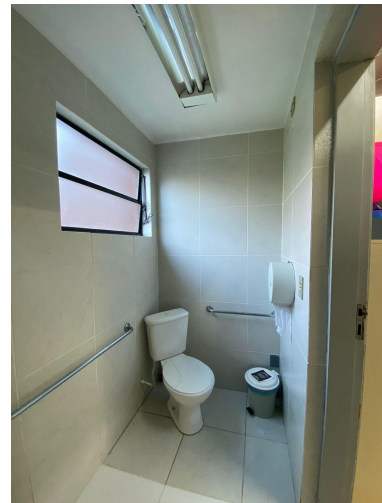
Figura 12: banheiro da Clínica Escola de Fisioterapia ESEFID. Fonte: primária.
