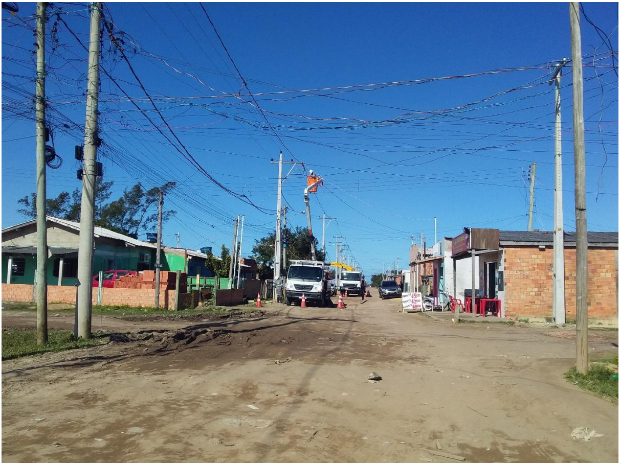
Figura 26: Instalação de poste de luz regular
