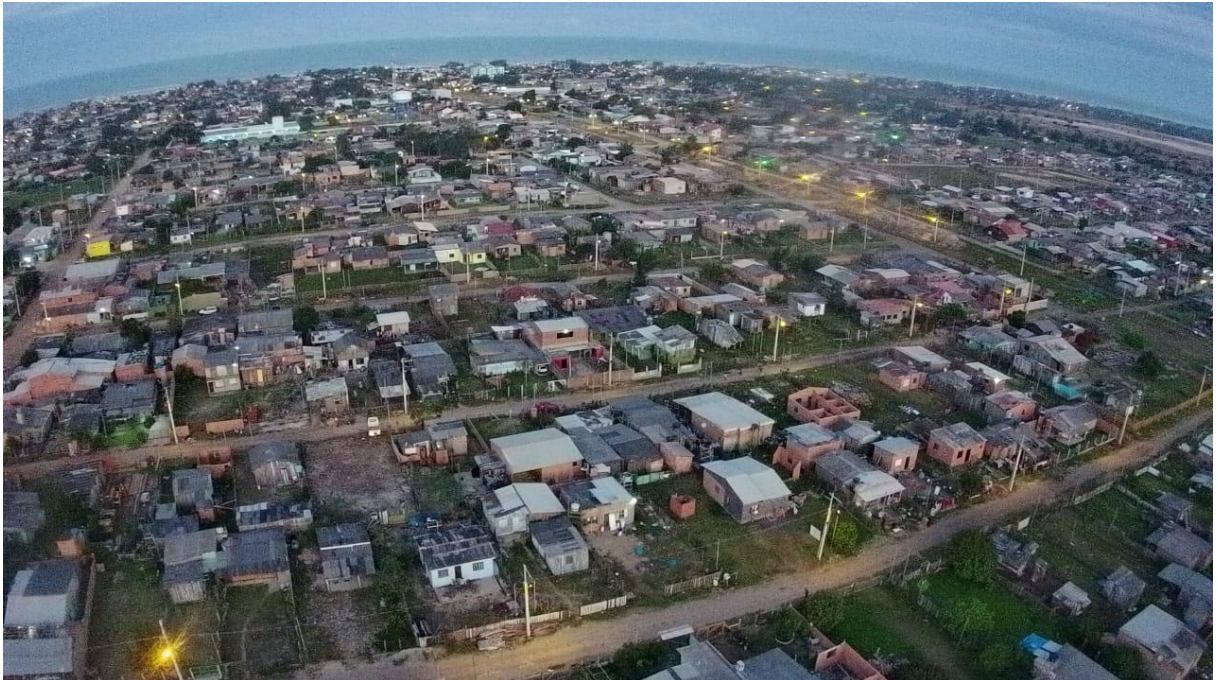
Figura 7- Vista panorâmica da Portelinha
